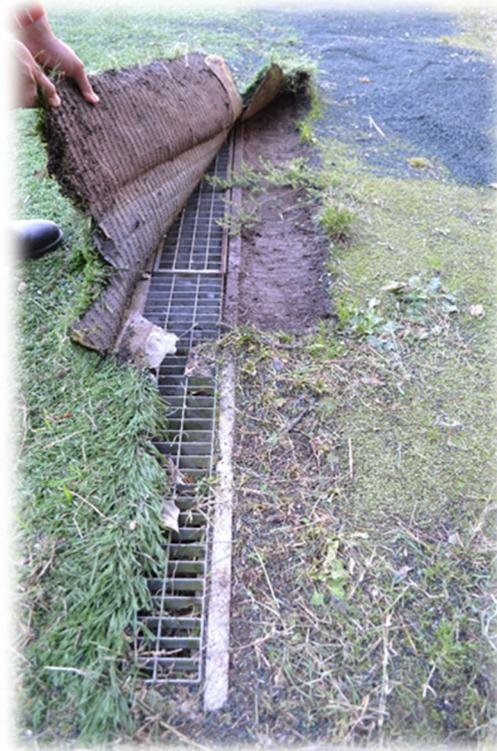
Stratigrafia esistente rilevata e canaline raccolta acqua perimetrali
