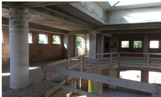
L'edificio è stato realizzato su una pianta rettangolare di circa mq. 290 e altezza interpiano variabile da ml. 4.30 (piano terra e primo) a ml. 3.00 (piano S1 e piano secondo); i piani primo e secondo sono stati "svuotati" nella parte della navata centrale per permettere l'illuminazione naturale del piano terra attraverso un lucernario a forma piramidale.
