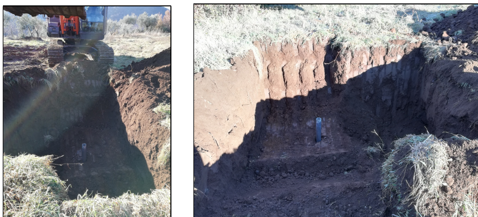
SCAVO GEOGNOSTICO Sc1 CON PRELIEVO DI CAMPIONE C1
