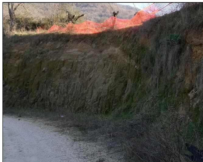
PARTICOLARE TUFI LITOIDI TAGLIO SU STRADA DI ACCESSO ZONA PEEP COLLE FATTORE
