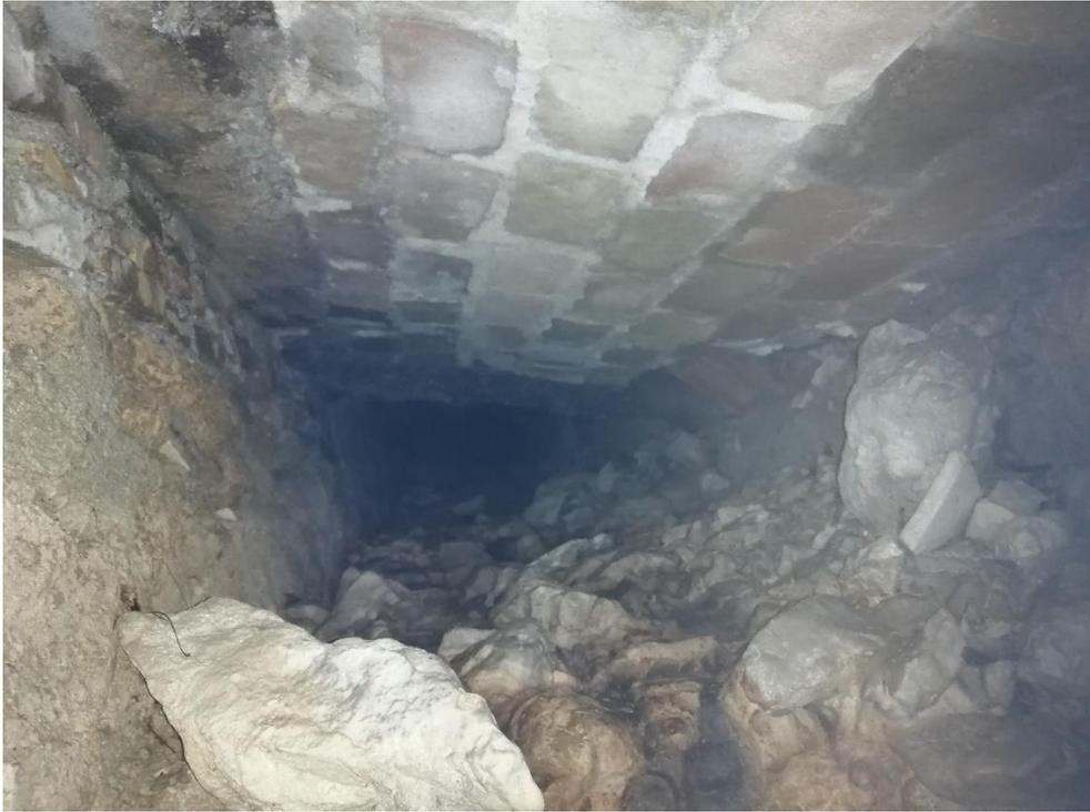
*Tratto finale del cunicolo ispezionato con evidente restringimento della sezione per progressivo riempimento*
