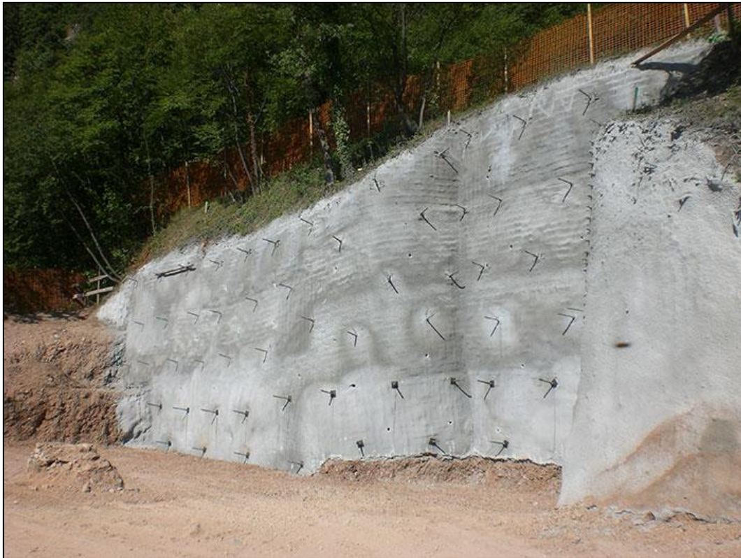
Figura 15 Sostegno in Spritz-Beton
