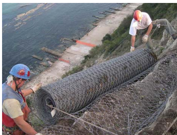
Figura 5 – immagine tipo installazione Rete paramassi
