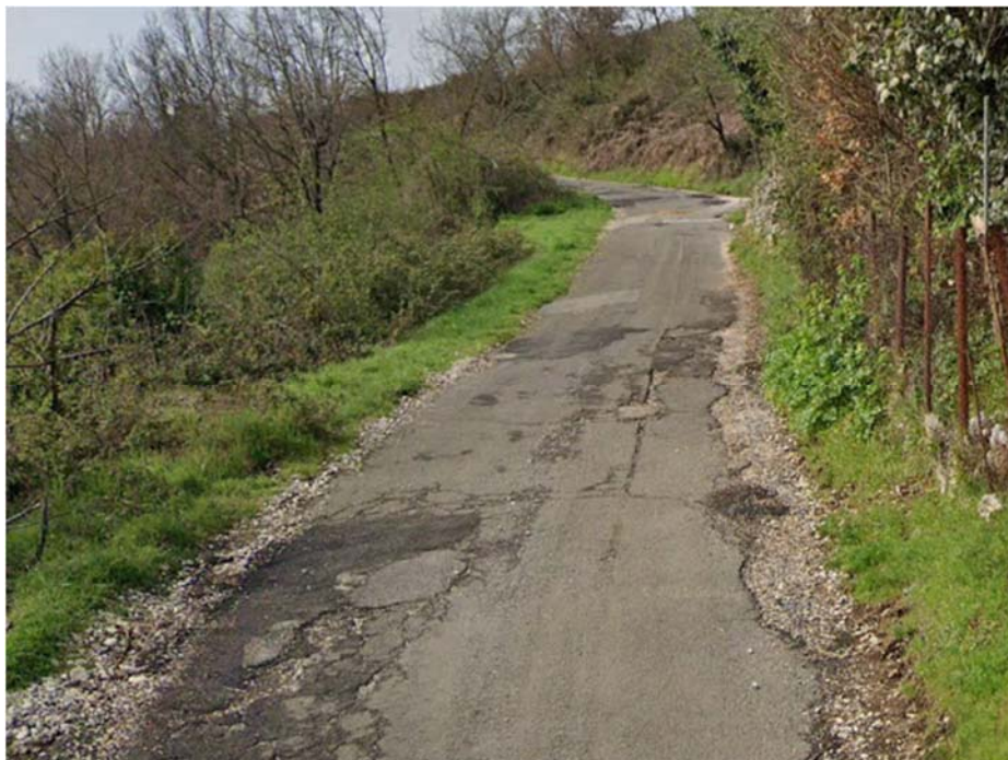
Figura 2 – Vista delle lesioni sulla viabilità
