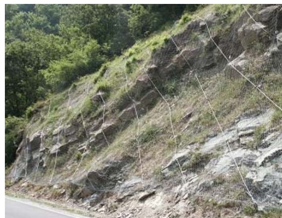
Figura 5 – immagine tipo installazione Rete paramassi
