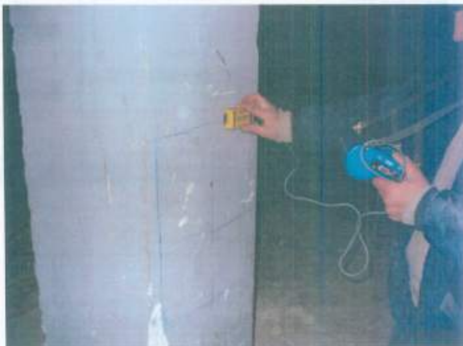
Verifiche pacometriche su pilastro
