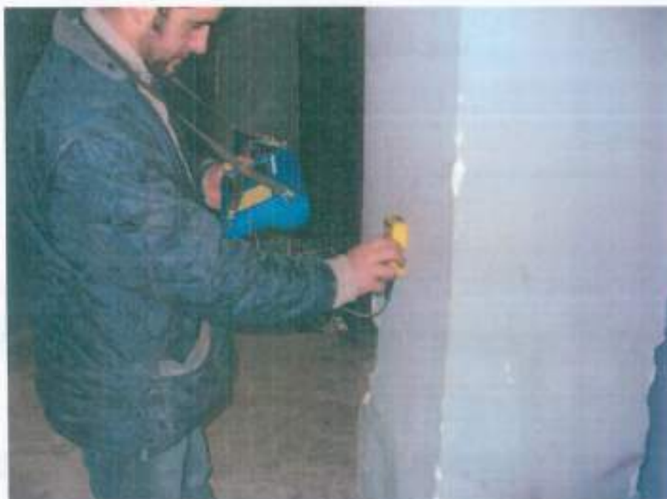
Verifiche pacometriche su pilastro
