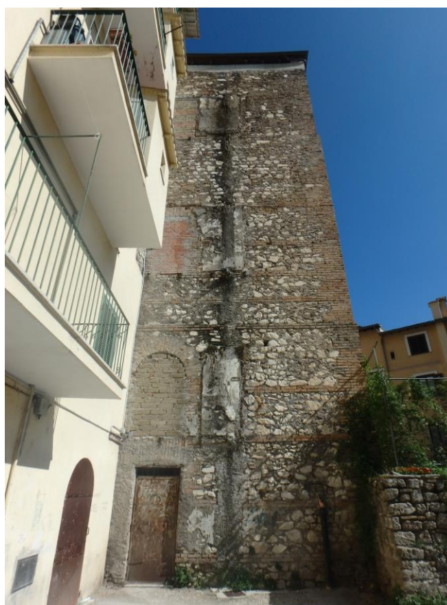
Foto 19 – Facciata ovest – contesto edilizio piazza Tozzi
