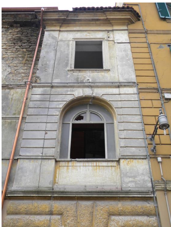
Foto 7 - Facciata nord – finestra ad arco a tutto sesto
