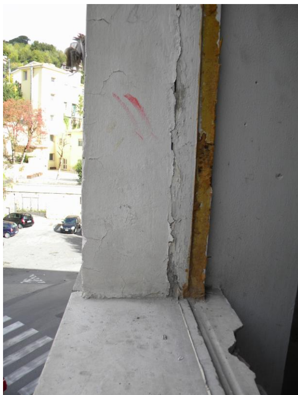
Foto 34 – Facciata nord – particolare finestra – imbotte in intonaco
