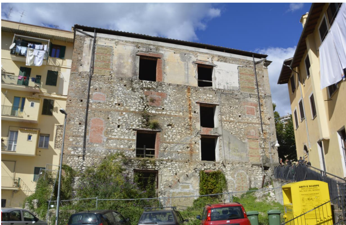
Foto 16 – Facciata sud – piazza Tozzi
