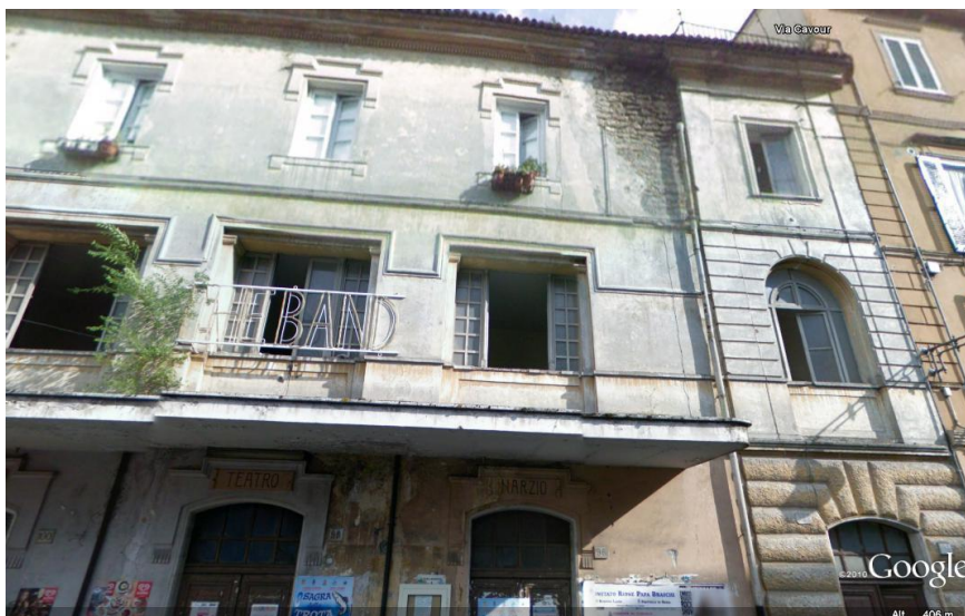
Foto 4 – La facciata nord prima della demolizione della pensilina in c.a.
