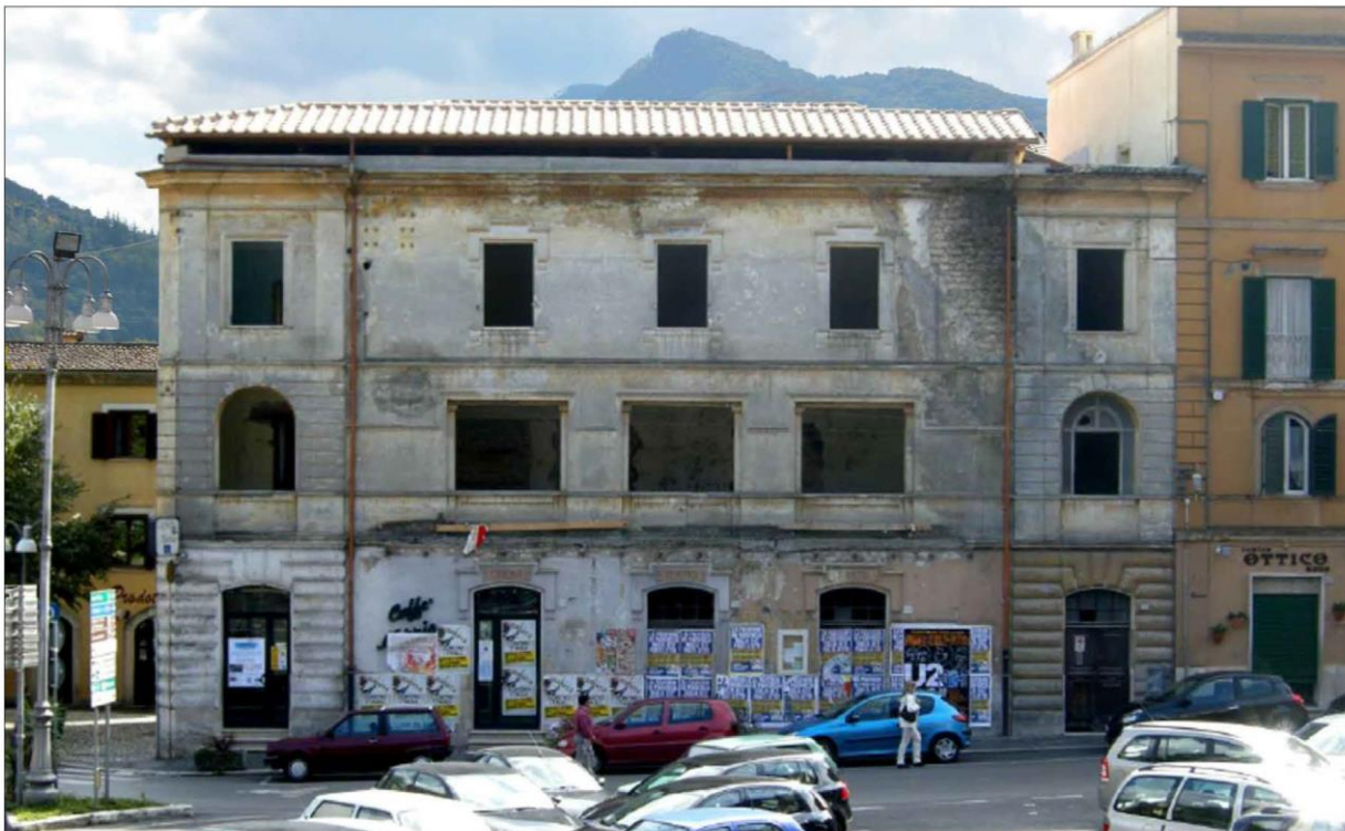
VISTA 2 ANTE OPERAM _ PROSPETTO NORD SU VIA CAVOUR
