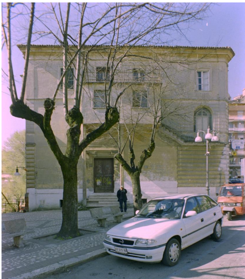
Foto 10 – Facciata est prima della demolizione delle superfetazioni
