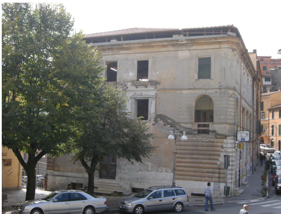
Foto 11 – Facciata est dopo la demolizione delle superfetazioni
