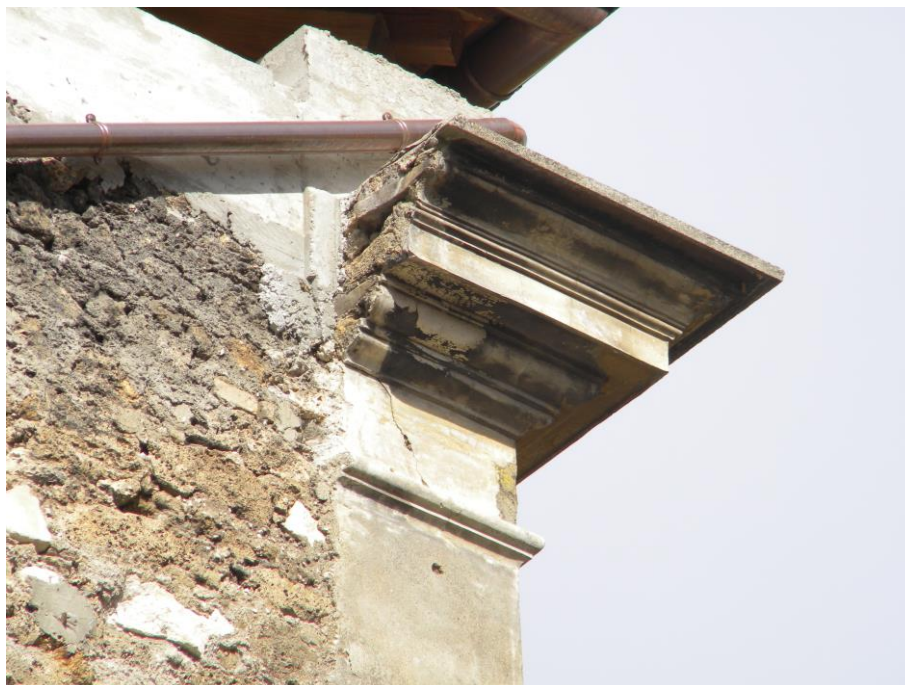
Foto 35 - Angolo edificio via Cavour – piazza Roma
