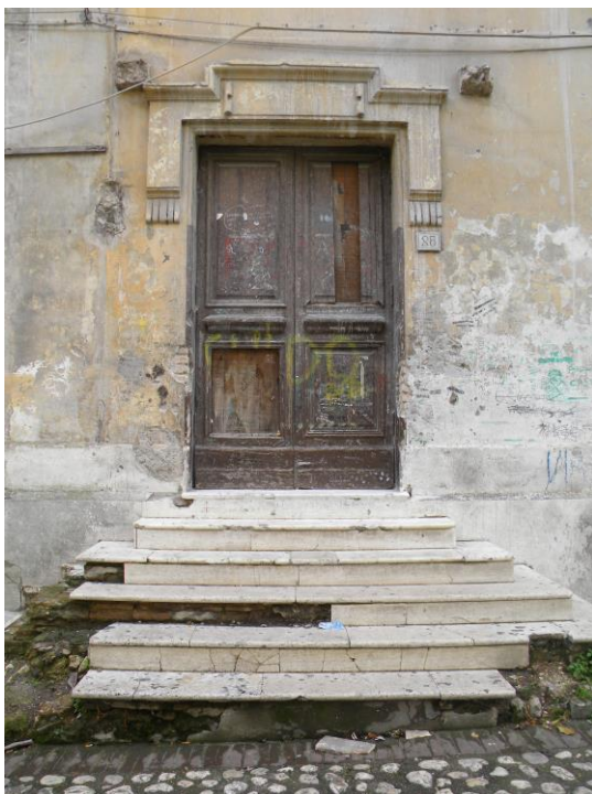
Foto 12 – Facciata est – Portone in legno con specchiature, scalinata in travertino ed elementi decorativi in intonaco
