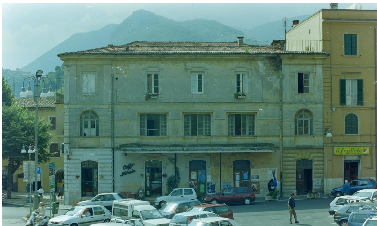
Foto 3 – Il teatro prima della demolizione delle superfetazioni
