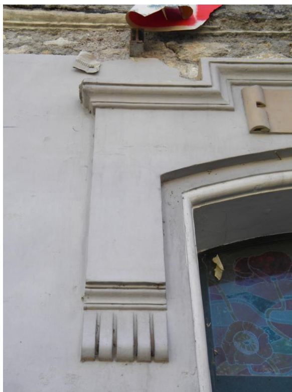
Foto 9 - Facciata nord – particolare apparato decorativo
