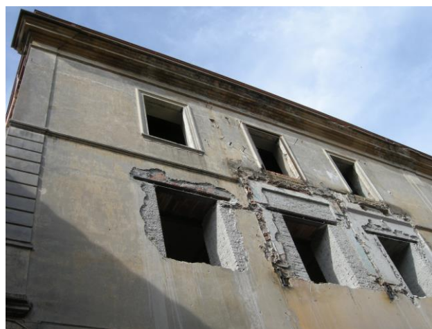
Foto 15 – Facciata est – segni dell'intervento di demolizione dei volumi incongrui
