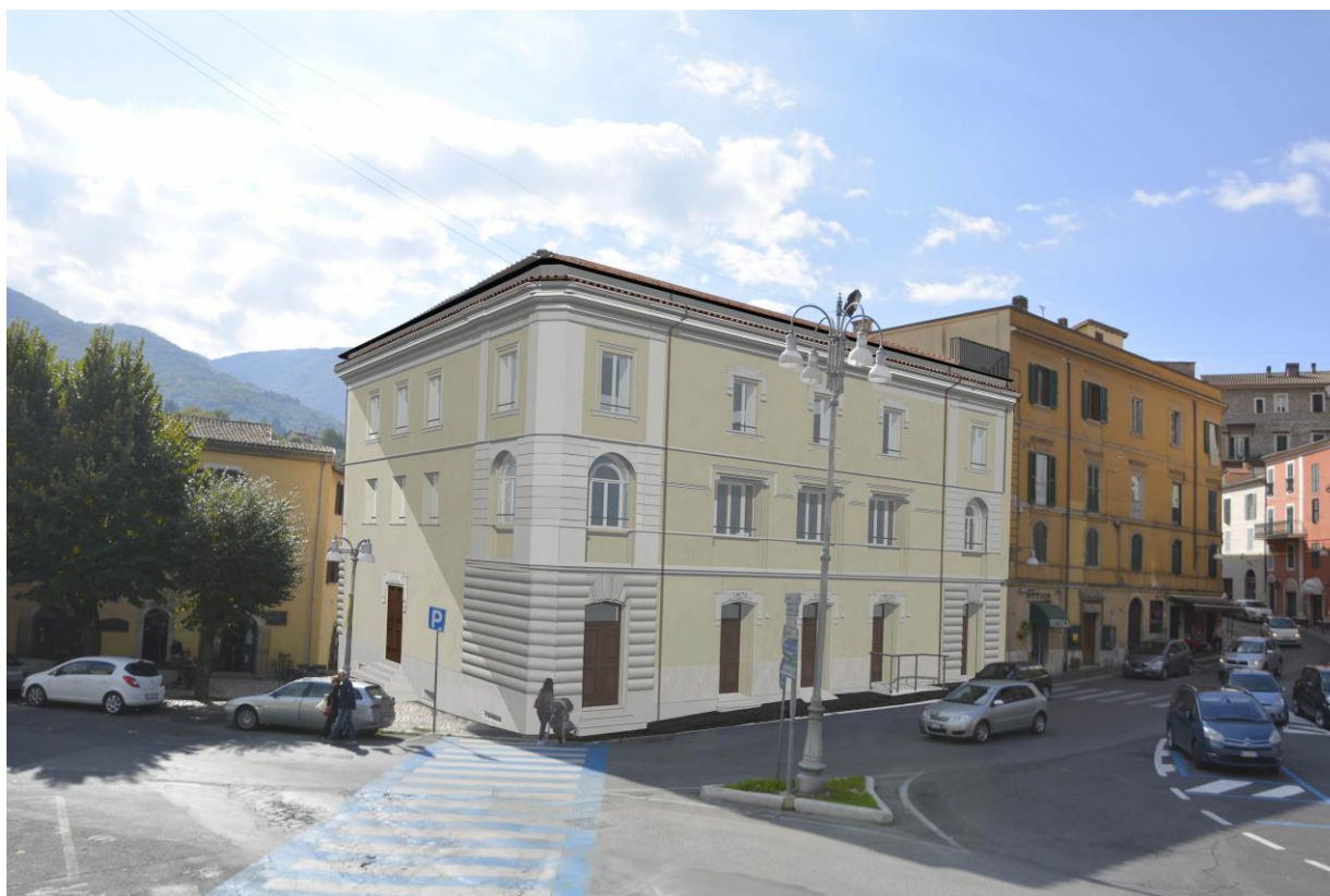
VISTA 1 POST OPERAM _ PROSPETTI NORD - EST SU VIA CAVOUR E PIAZZA ROMA
