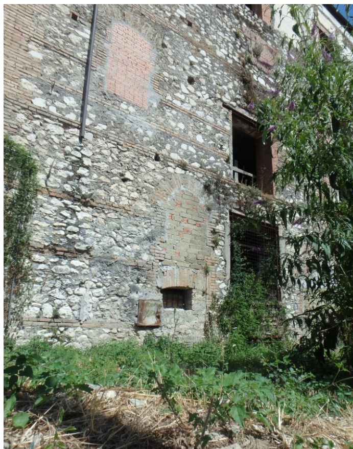
Foto 18 – Facciata sud - interrimento dell'area
