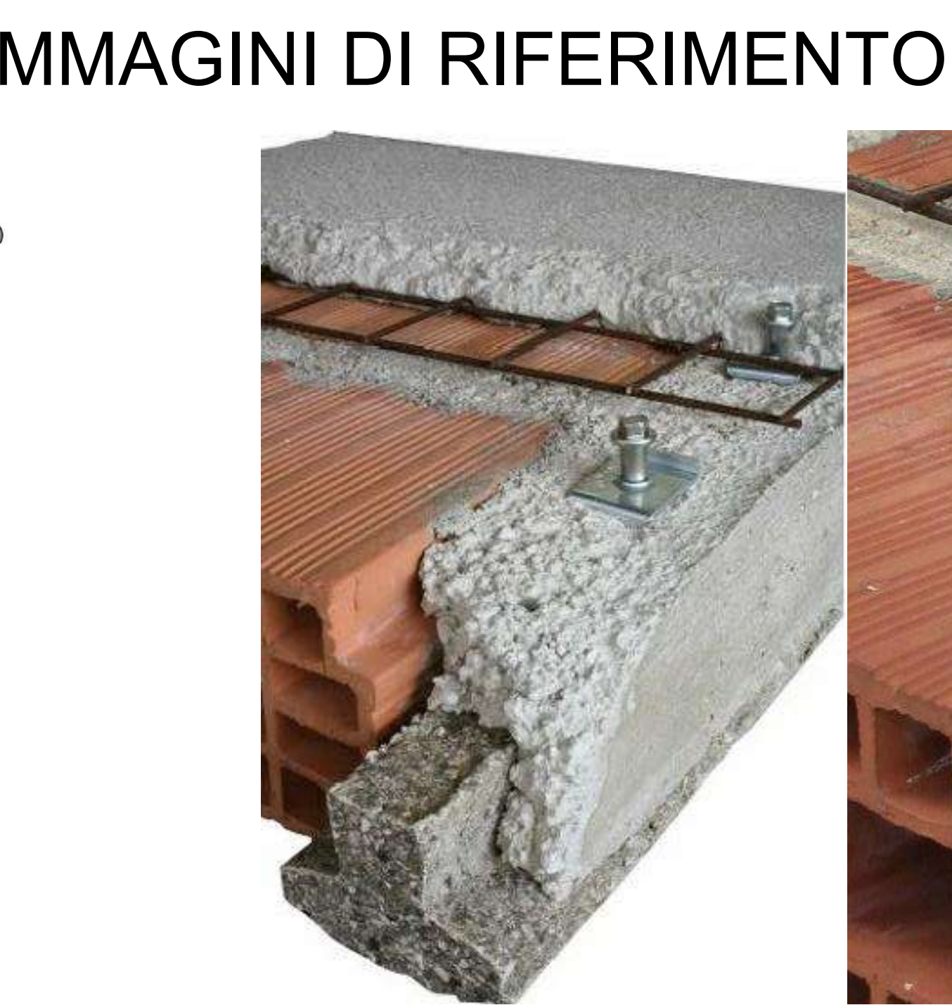
Intervento consolidamento solaio in latero-cemento
