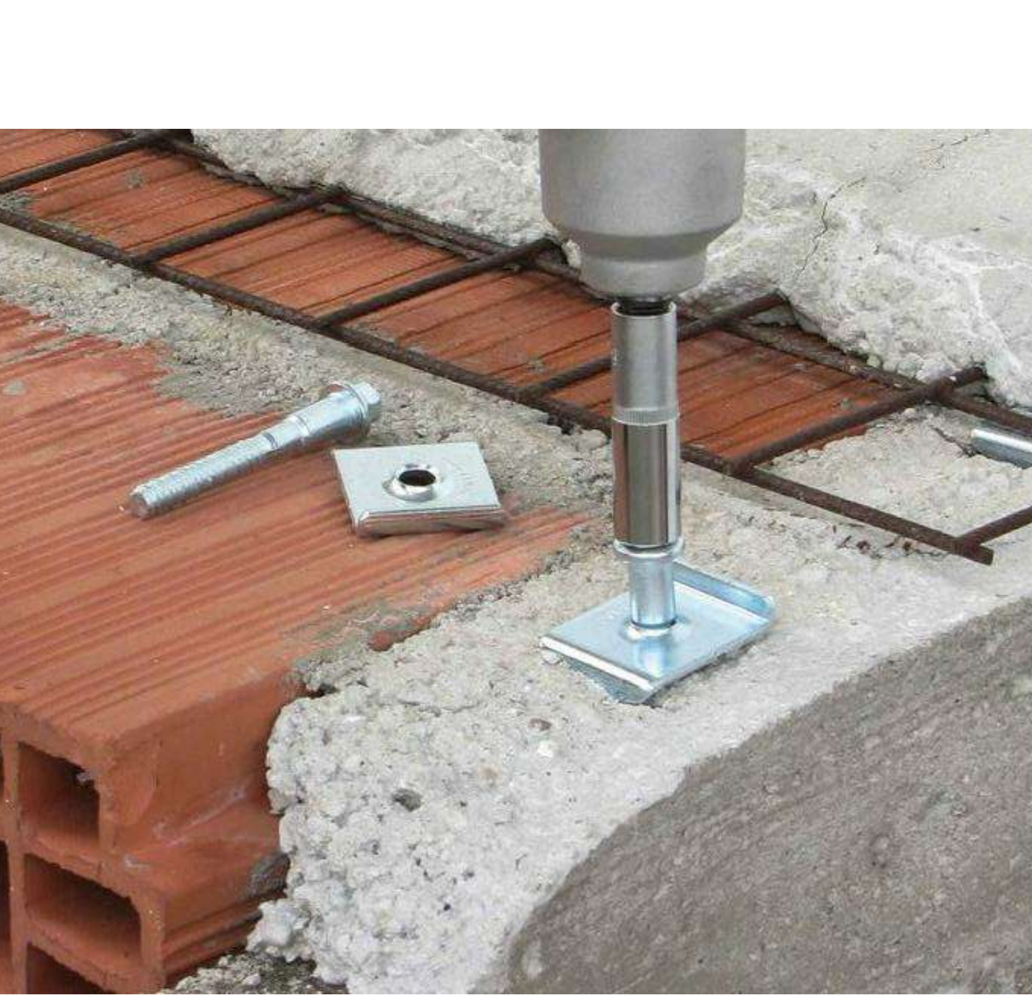
Intervento consolidamento solaio in latero-cemento
