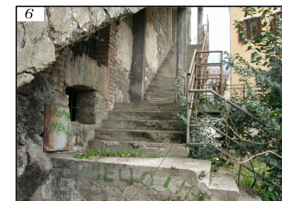
Nuova scala in c.a. utilizzata come uscita di sicurezza dalla platea (C)
