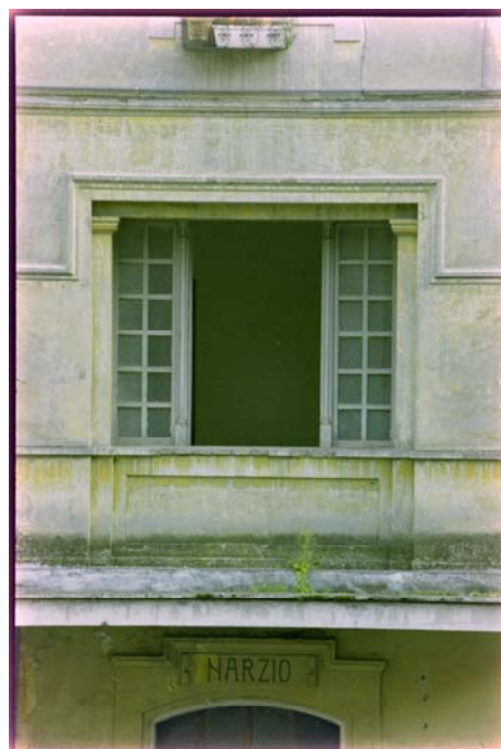
Dettagli del prospetto su piazza della Resistenza (prima del 1949-50).
