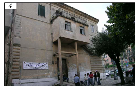
Veduta del volume aggiunto per l'ampliamento della cabina proiezione (A)
