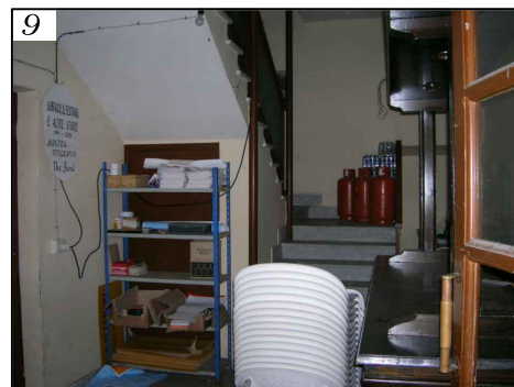
Veduta dal piano terra della nuova scala in c.a. che conduce al piano galleria (F)
