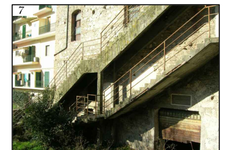
Vedute delle due nuove scale utilizzate come uscite di sicurezza dalla platea e dalla galleria realizzate in c.a. (C)
