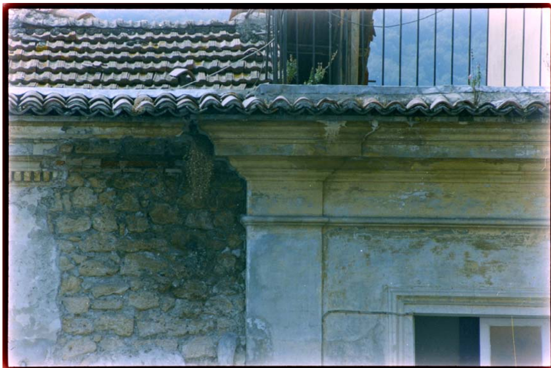
Dettaglio della copertura (prima del 1949-50).
