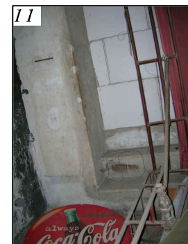
Chiusura dell'apertura che collegava il palcoscenico alla scala in muratura (L)
