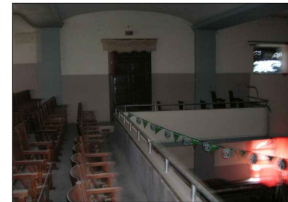
4. Veduta dell'uscita di sicurezza dalla galleria (B)
