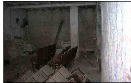
1. Veduta del pilastro a sostegno della Galleria (B)
