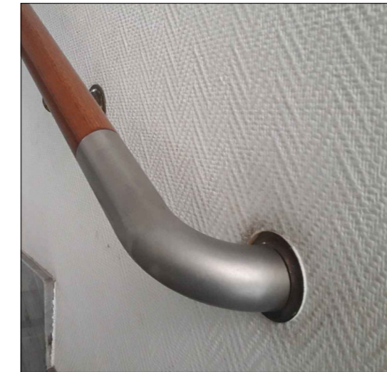
DETTAGLIO PARTE TERMINALE CORRIMANO TIPOLOGIA A
