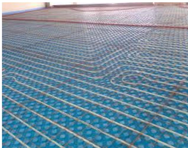
L'impianto di riscaldamento sarà del tipo a collettori alimentati dall'impianto centralizzato. Da ciascun collettore si diramano le tubazioni dell'impianto a pannelli radianti a pavimento. L'impianto è controllato da cronotermostati, uno per collettore, i quali agiscono sulle valvole di zona dei rispettivi collettori.
