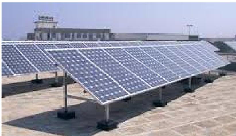
L'impianto fotovoltaico sarà costituito da n°1 generatore fotovoltaico, composto da n° 30 moduli fotovoltaici e da n°1 inverter con pannelli posizionati sulla copertura dell'edificio a potenza nominale complessiva è di 15 kWp .
