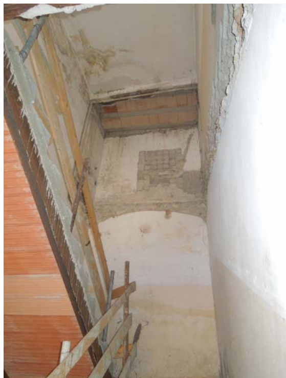
Scala di servizio al lato destro dell'area palcoscenico: intradosso dell'ultima rampa.
