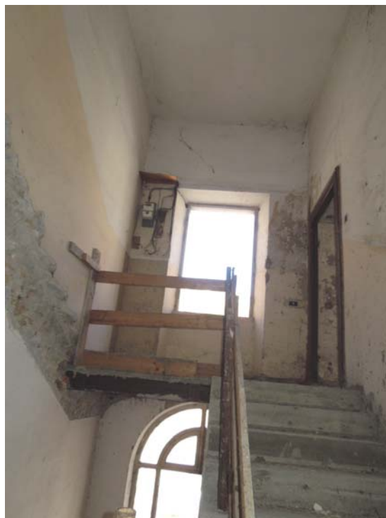
Scala di servizio al lato destro dell'area palcoscenico: estradosso dell'ultima rampa.
