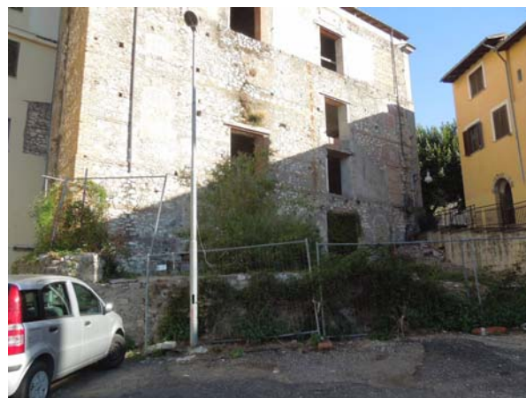
Area di pertinenza del teatro verso Piazza Tozzi vista dal parcheggio.
