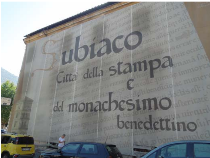
Facciata su Piazza della Resistenza.
