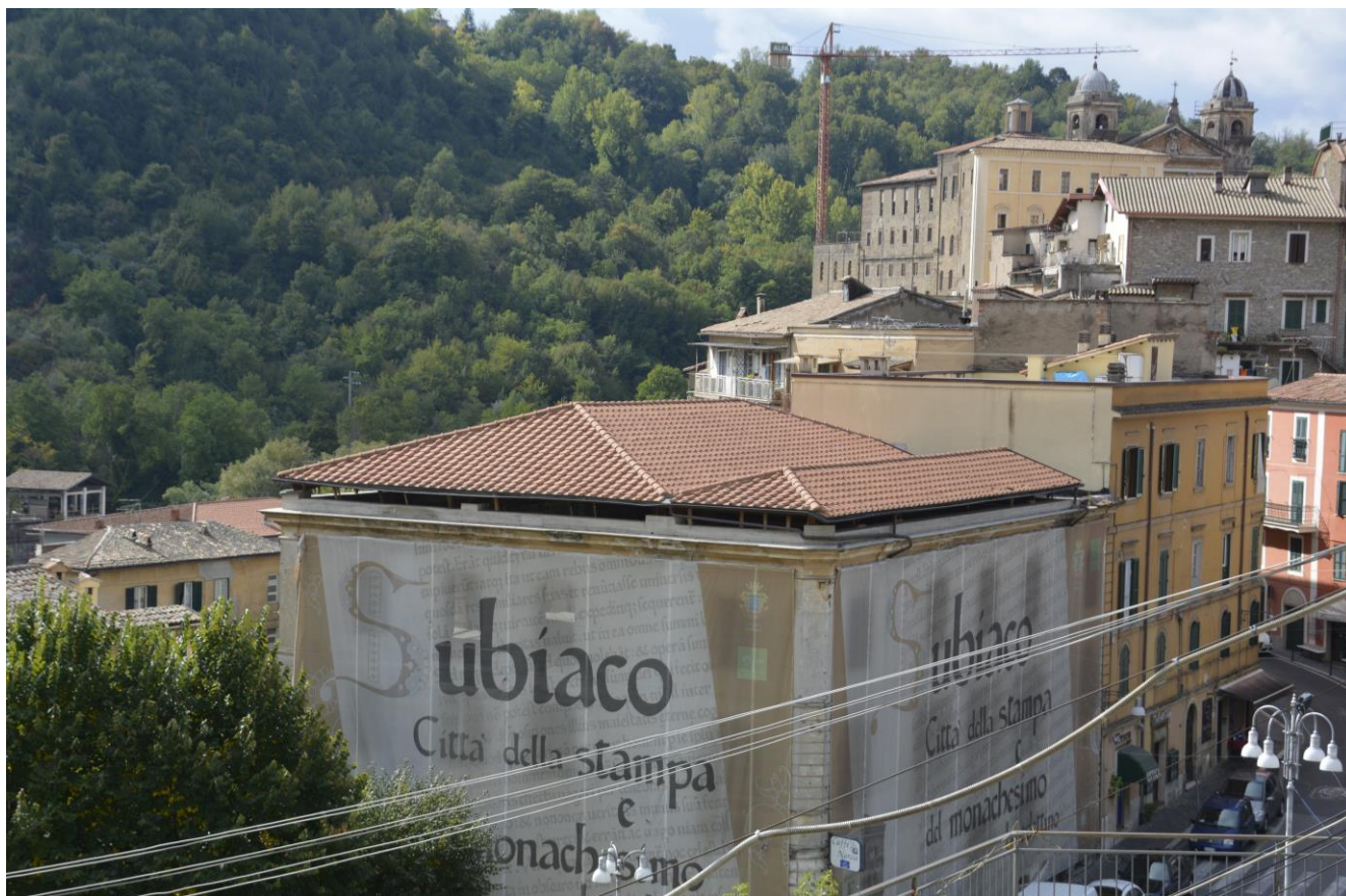
Vista 36 – Vista del tetto su Via Cavour e Piazza Roma
