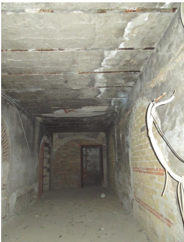
Vista 8 - Foto verso la scala di servizio
