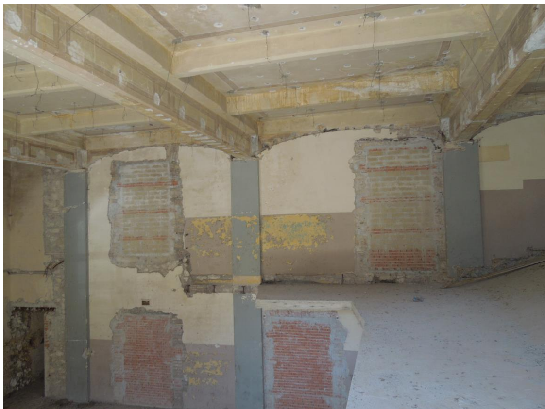
Vista 20 - Foto laterale della soletta della galleria
