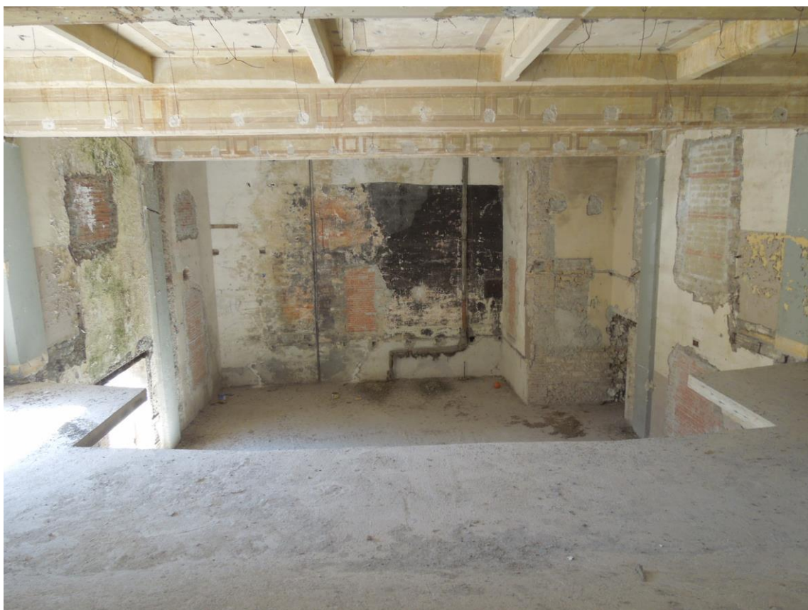
Vista 21 - Vista dalla galleria verso l'area palcoscenico
