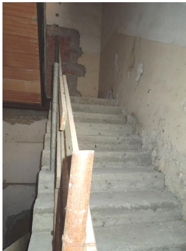
Vista 27 - Dettaglio delle rampe della scala di servizio
