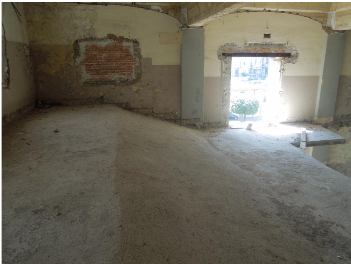
Vista 19 - Dettaglio della soletta della galleria
