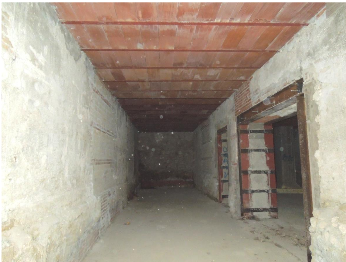
Vista 3 - Foto dell'ambiente di arrivo della scala di servizio
