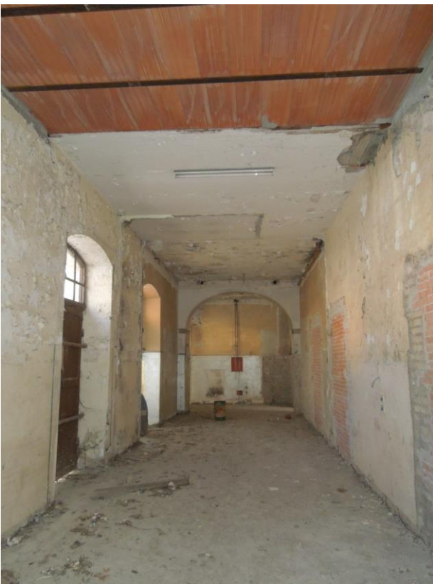
Vista 10 - Foto dell'ambiente destinato ad hall
