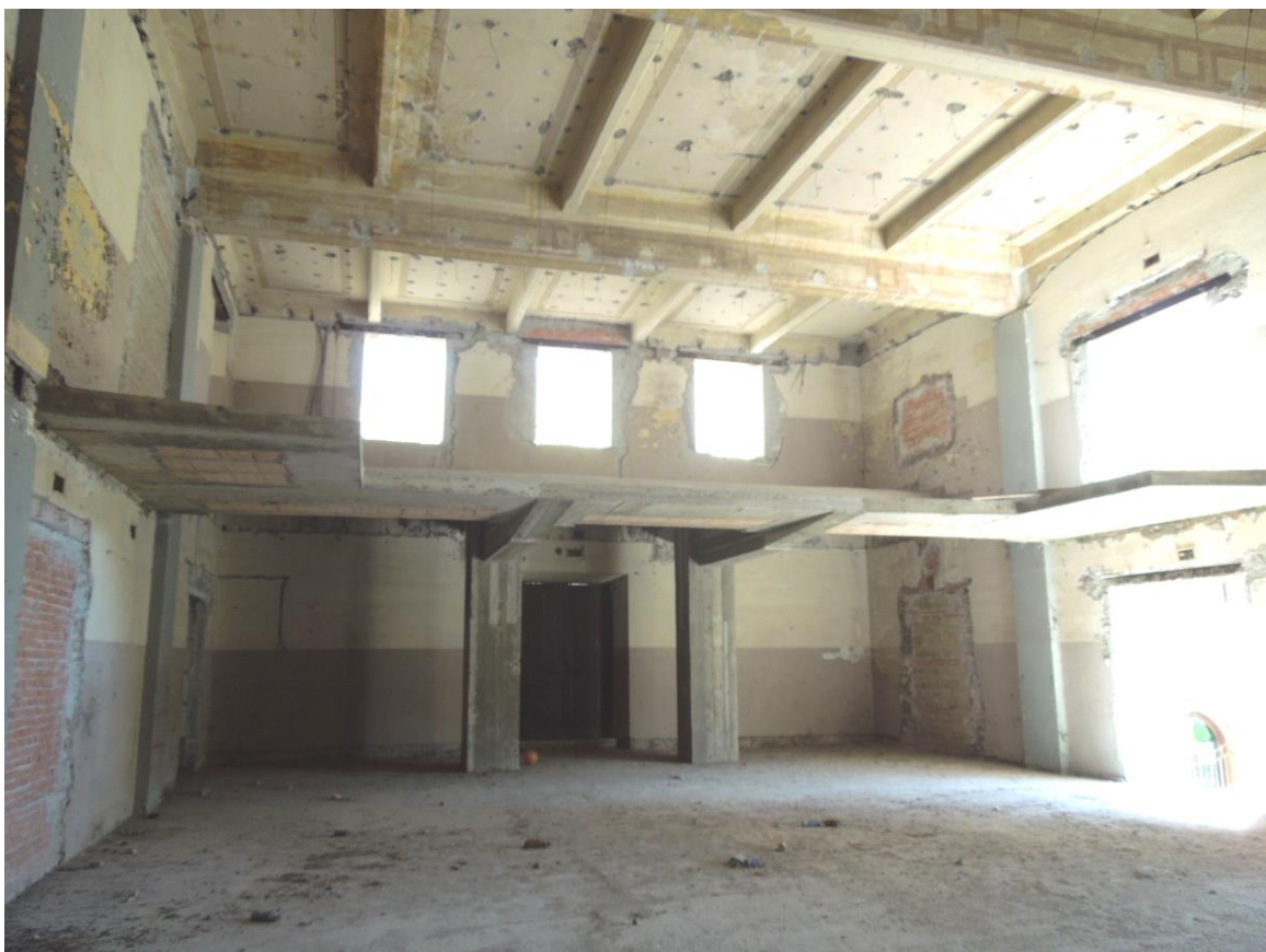
Vista 12 - Foto dalla platea verso la galleria
