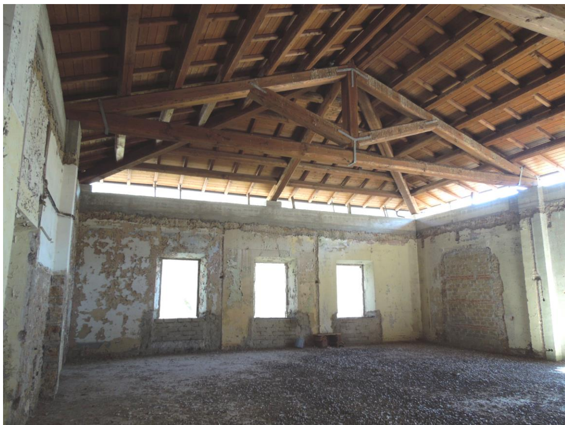
Vista 24 - Foto del sottotetto e relativa copertura
