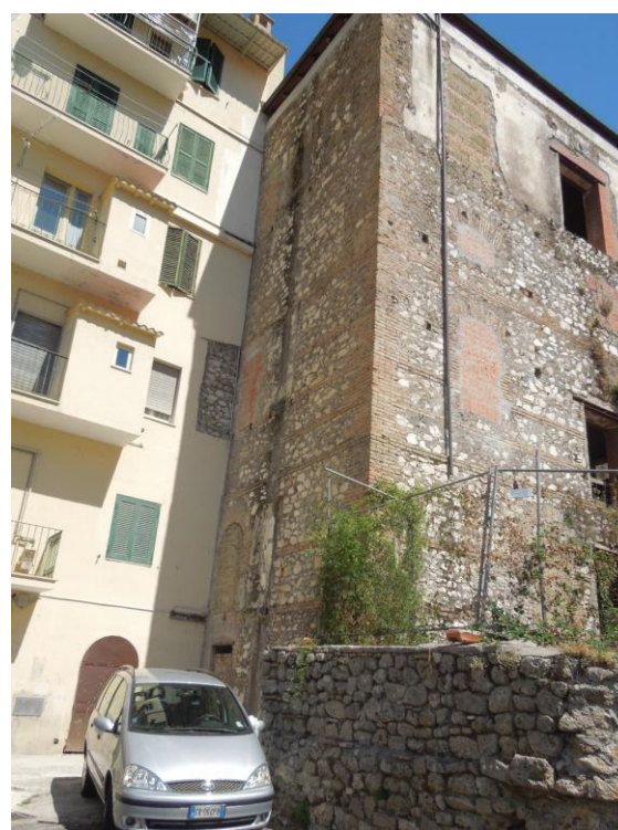
Vista 29 - Prospetto laterale su Piazza Tozzi
