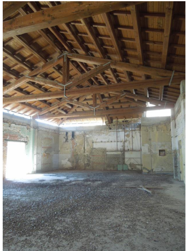
Vista 23 - Foto del sottotetto e relativa copertura
