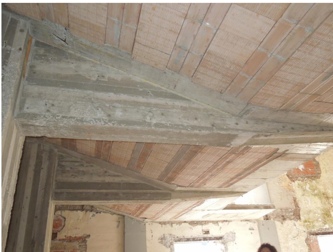
Vista 13 - Dettaglio della struttura di sostegno della galleria
