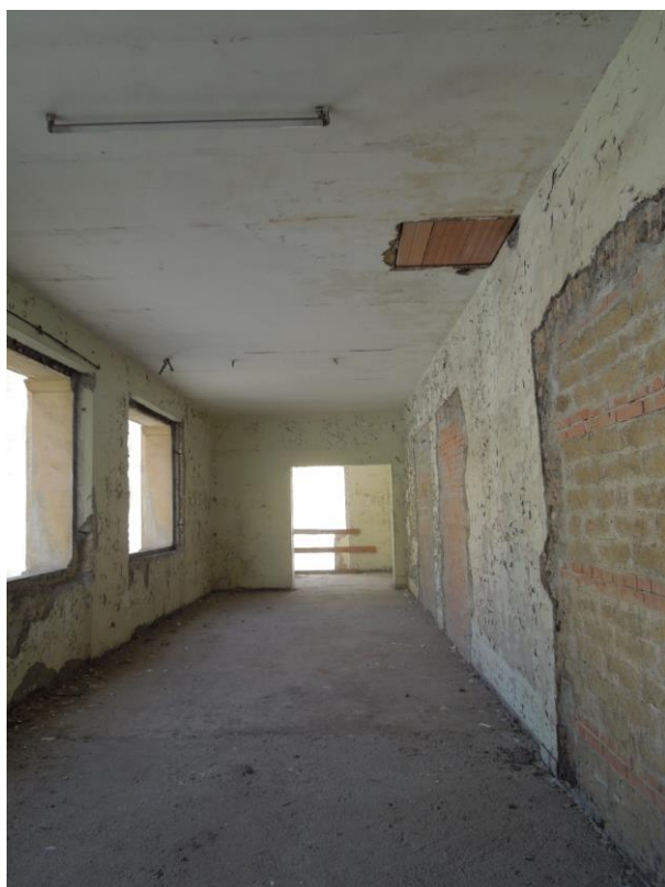
Vista 16 - Foto dell'ambiente destinato ad uffici e sosta pubblico al piano galleria
