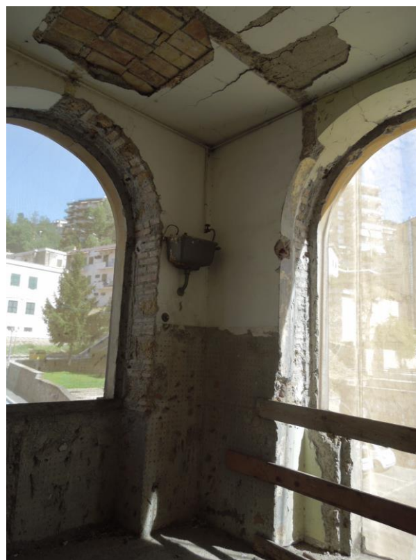
Vista 17 - Dettaglio delle aperture del futuro bagno del piano galleria
