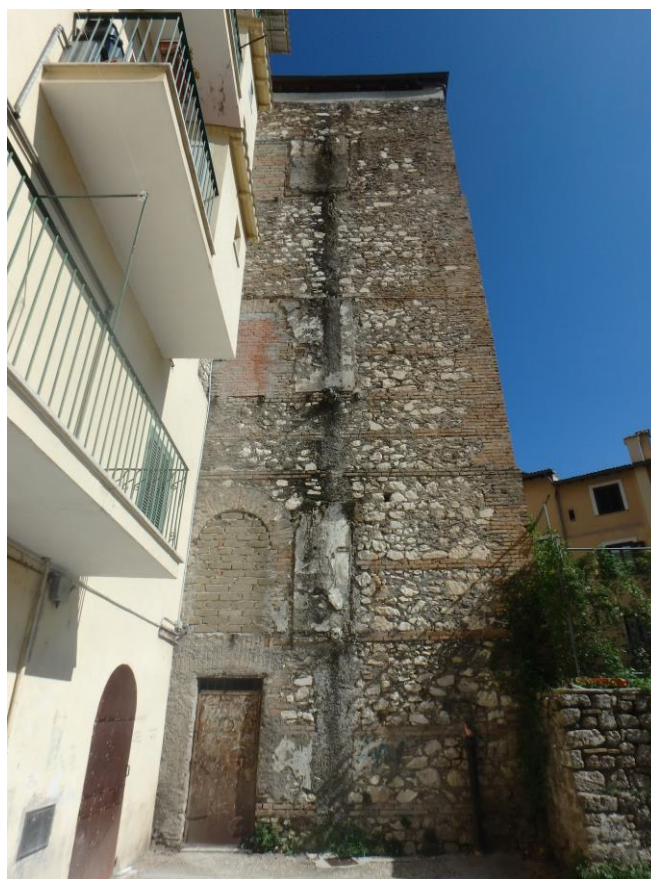
Vista 35 – Prospetto laterale su Piazza Tozzi
