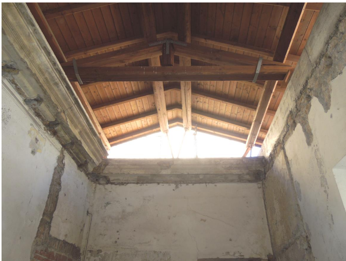
Vista 25 - Foto del sottotetto e relativa copertura
