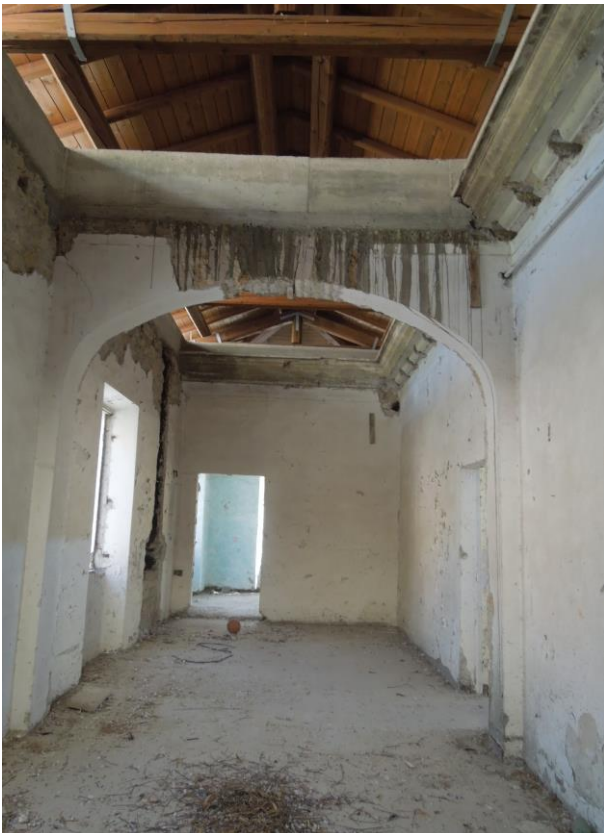
Vista 22 - Foto dell'ambiente di arrivo della scala di servizio
