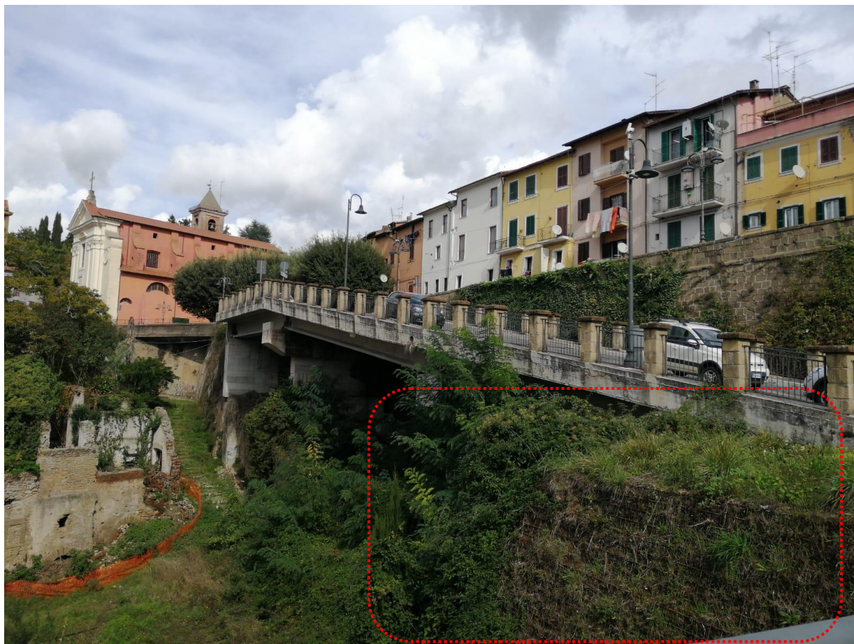
Veduta della rampa di ingresso dalla parte bassa del parcheggio nella quale si possono notare anche le strutture di sostegno realizzate con la tecnica delle terre rinforzate
