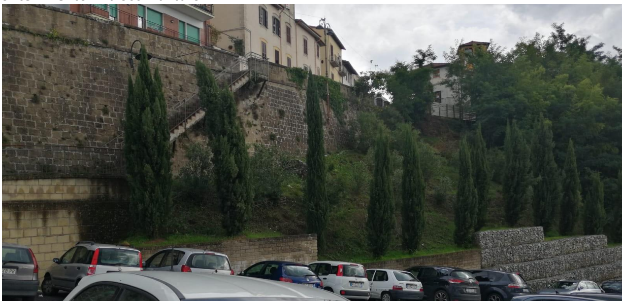
VEDUTA DAL PARCHEGGIO VERSO IL VERSANTE E LA STRADA PROVINCIALE N.155
