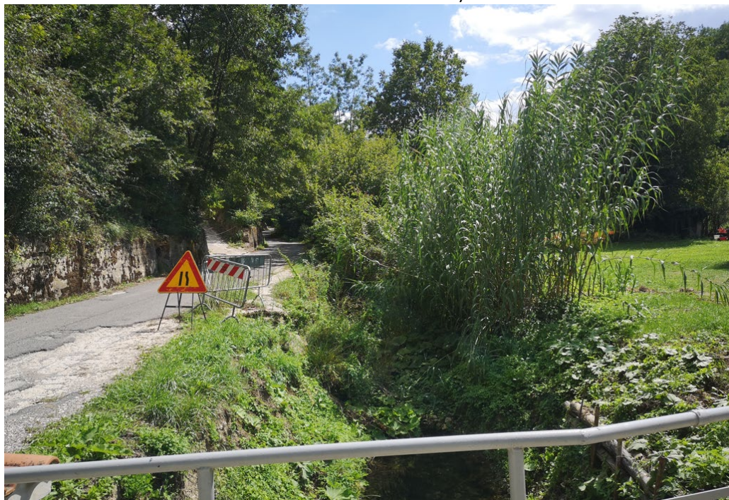
Figura 13 – Tratto inferiore del fondovalle del Fosso Riarco: si osservano scalzamenti sulla sponda destra con franamento di un tratto della sede stradale
