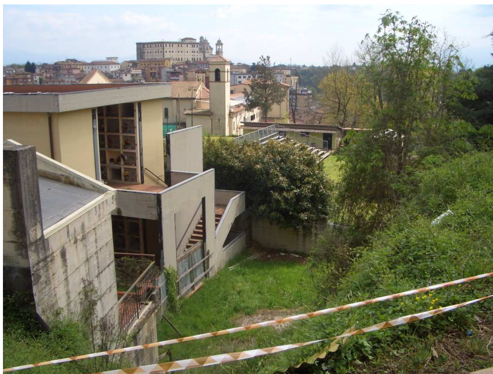
Fotografia A: Interventi 1A-1B
