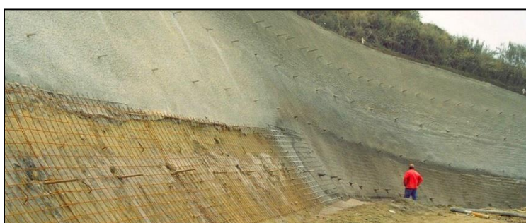
Esempio di realizzazione di parete chiodata
