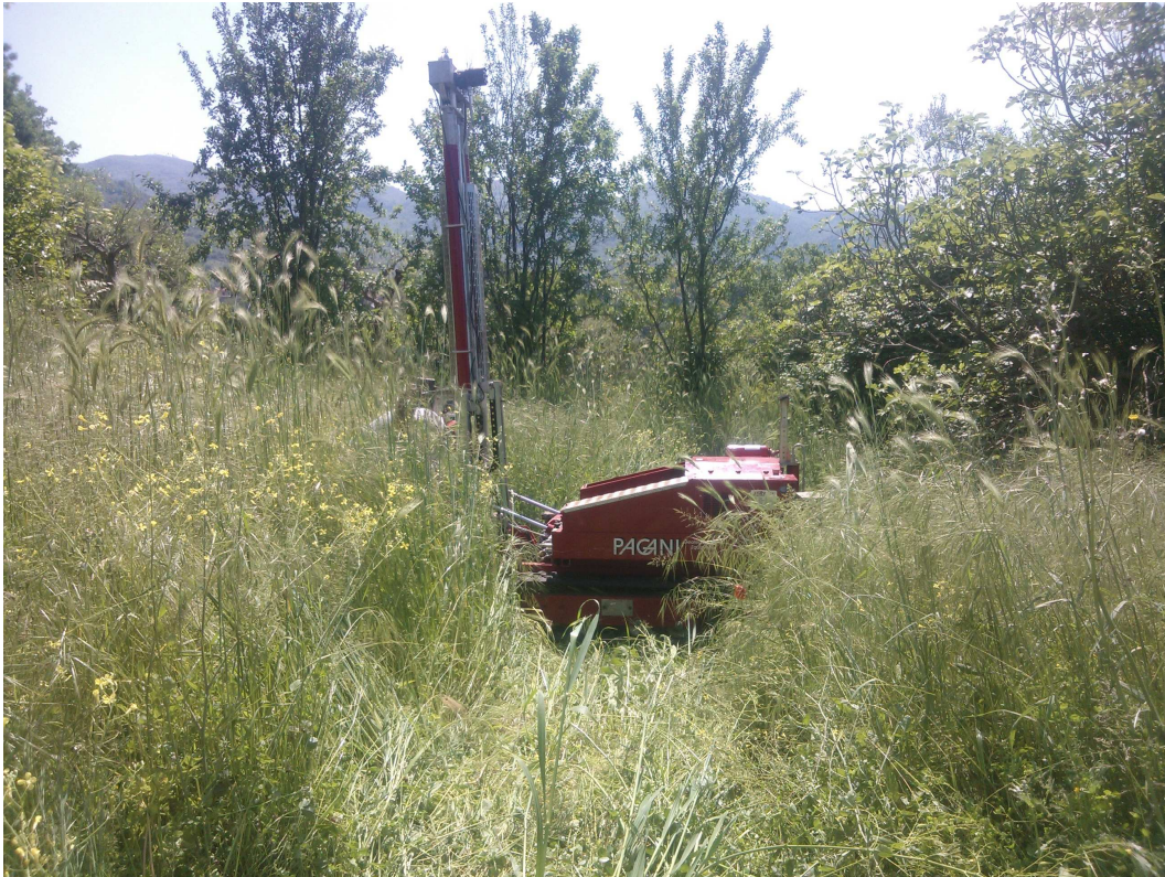
Foto 7 – Esecuzione DPSH n. 3
