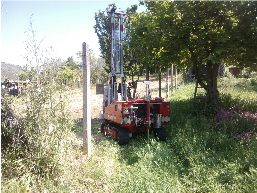
Foto 5 – Esecuzione DPSH n. 1
