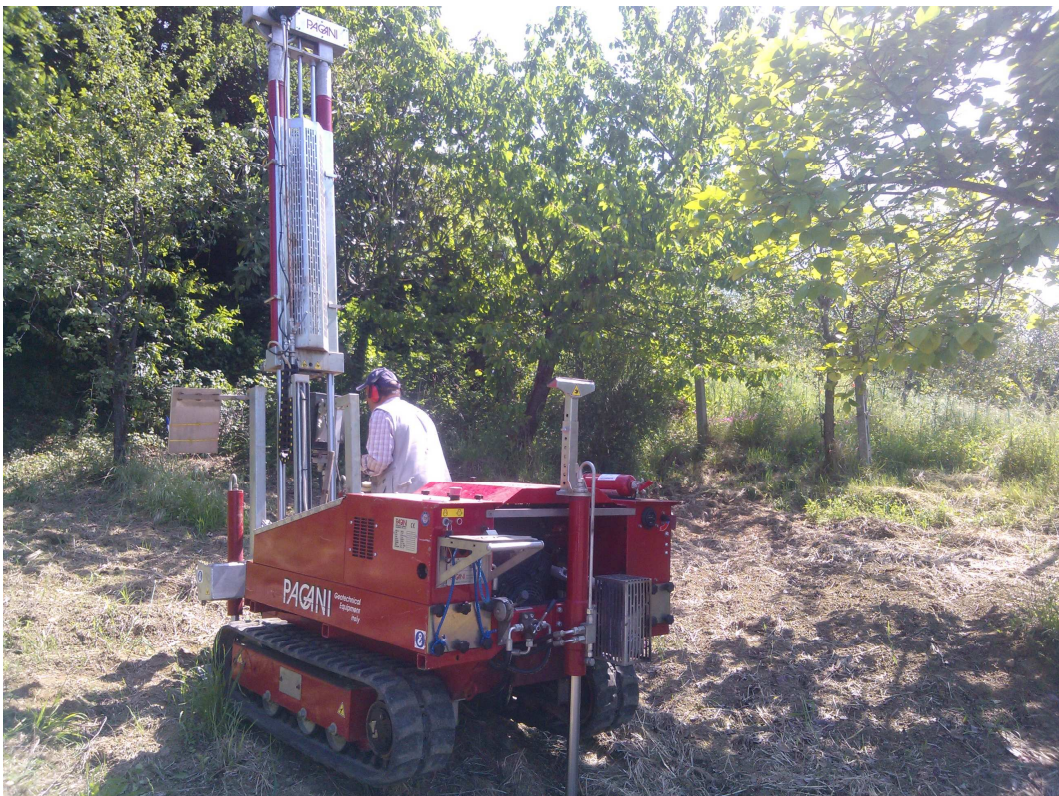
Foto6 – Esecuzione DPSH n. 2
