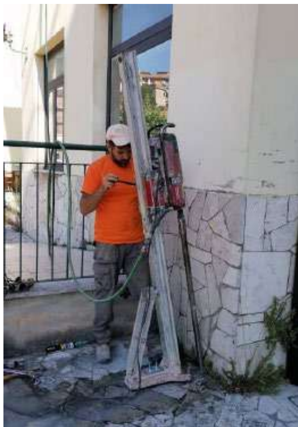
Foto 7 – Carotaggio inclinato nelle fondazioni – SF3 – Corpo A
