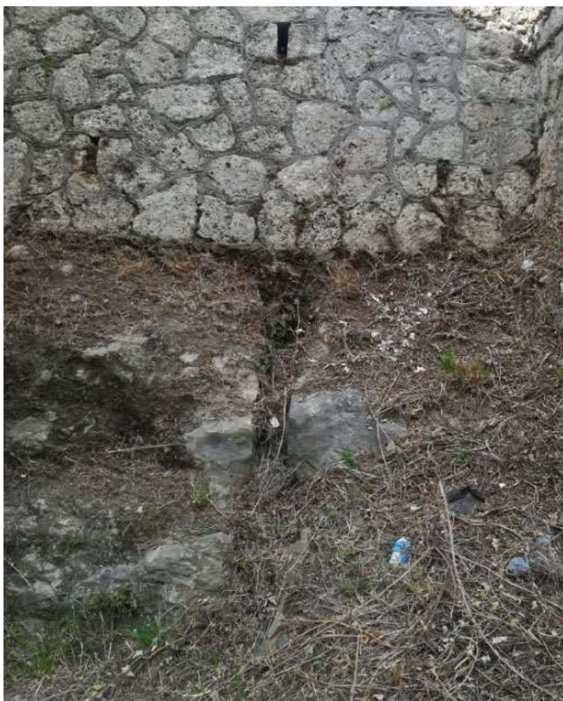
Foto 29 – Rilievo geostrutturale – stazione A
