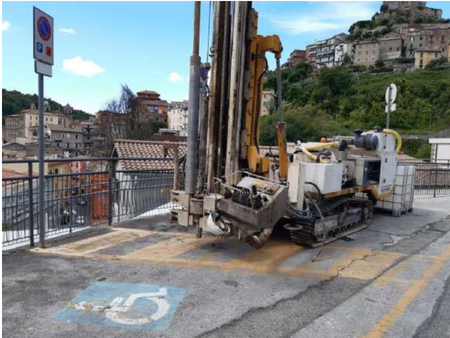
Foto 2 – Sondaggio S2p – Via Fogazzaro
