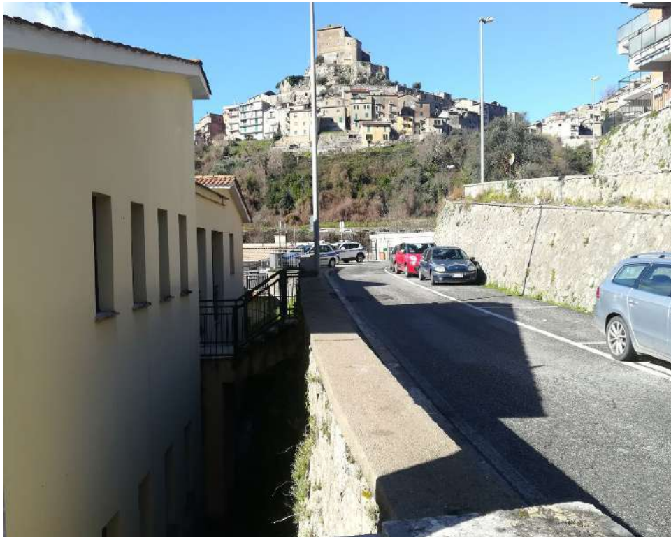
Foto 9 – Muro in pietrame tra via A.Fogazzaro e la Scuola Materna (Corpo B)
