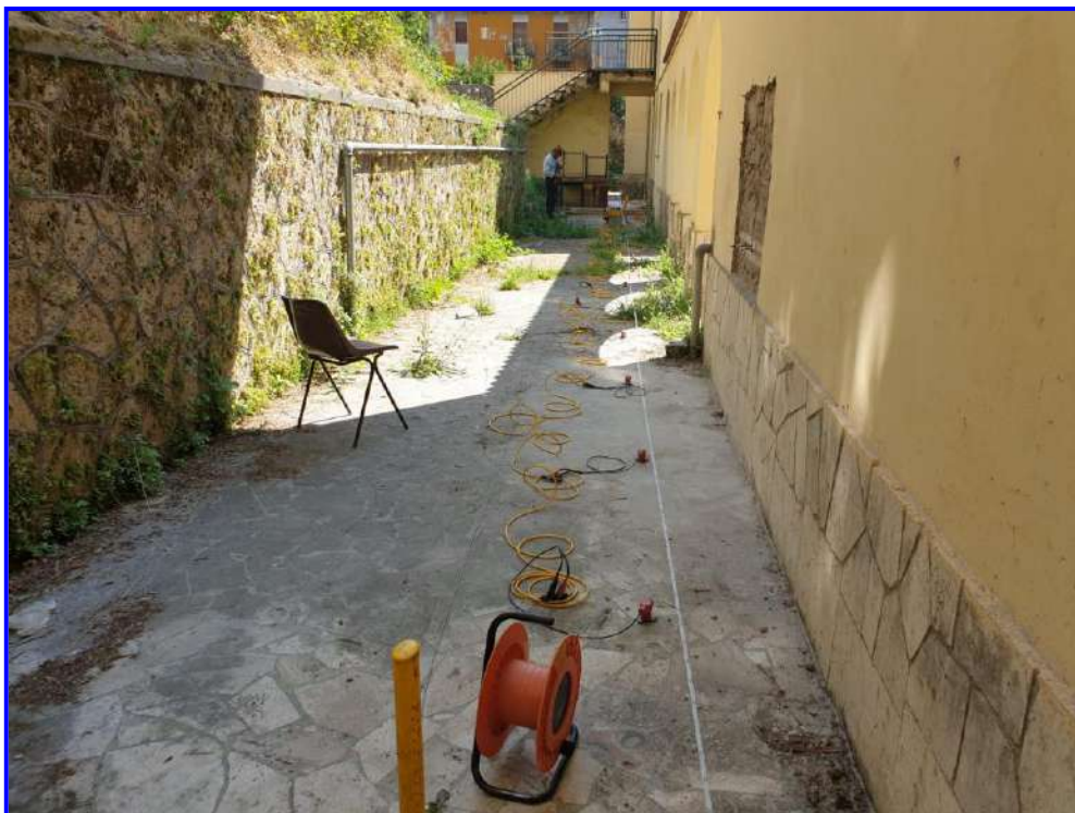
Prospezione sismica MASW n.2
