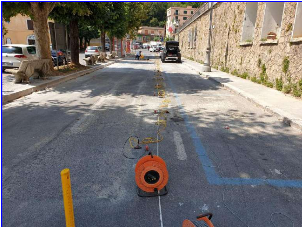
Prospezione sismica MASW n.3
