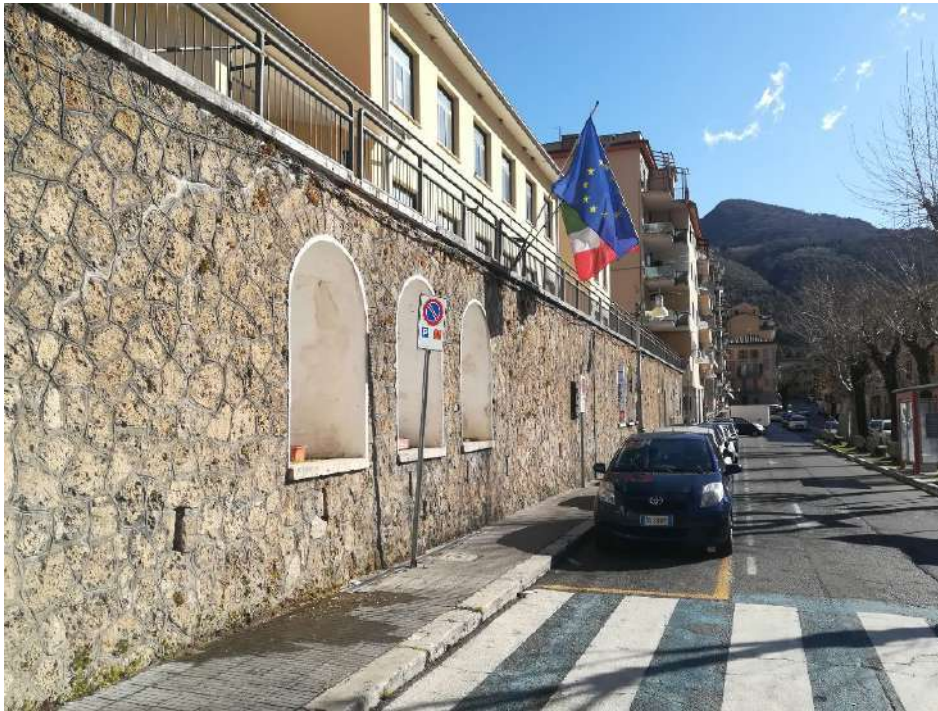
Foto 10 – Muro in pietrame su via Papa Braschi, a valle della Scuola elementare - Corpo A
