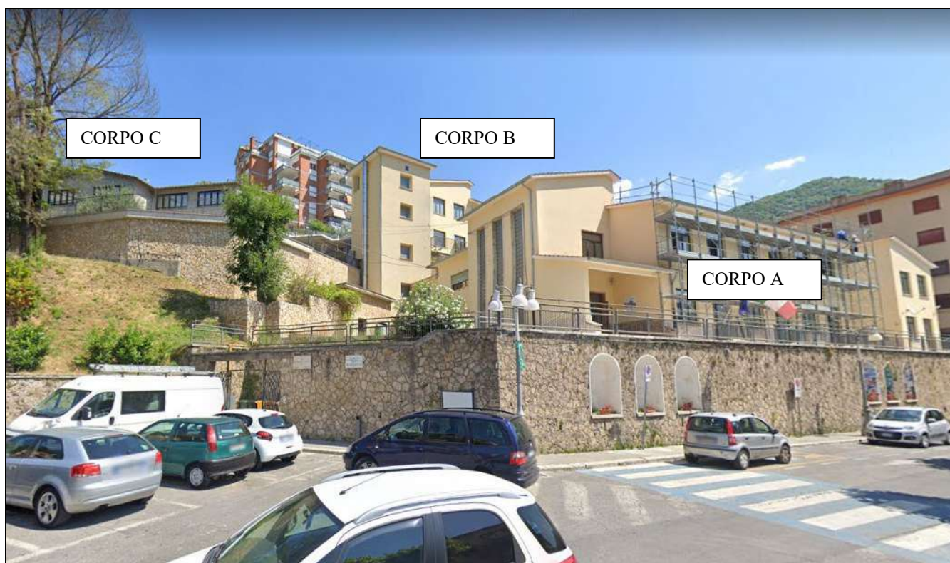
Foto 1 – Vista generale del Plesso Scolastico di Via A.Fogazzaro
