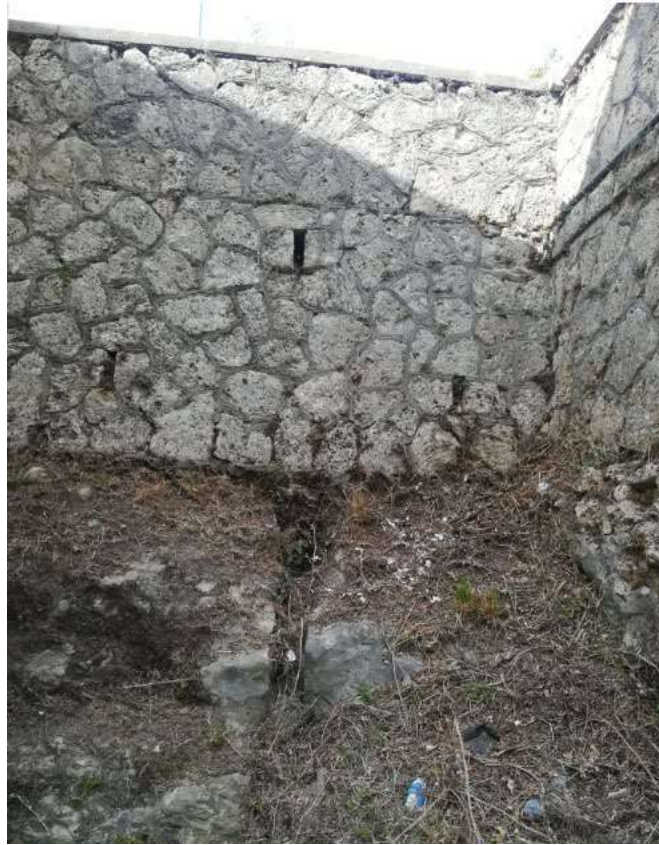
Foto 14 – Bancate di arenarie mediamente fratturate su cui poggia il muro di via A. Fogazzaro
