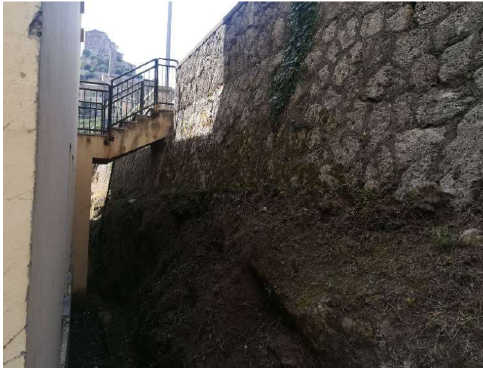
Foto 15 – Bancate di arenarie mediamente fratturate su cui poggia il paramento murario di via A. Fogazzaro
