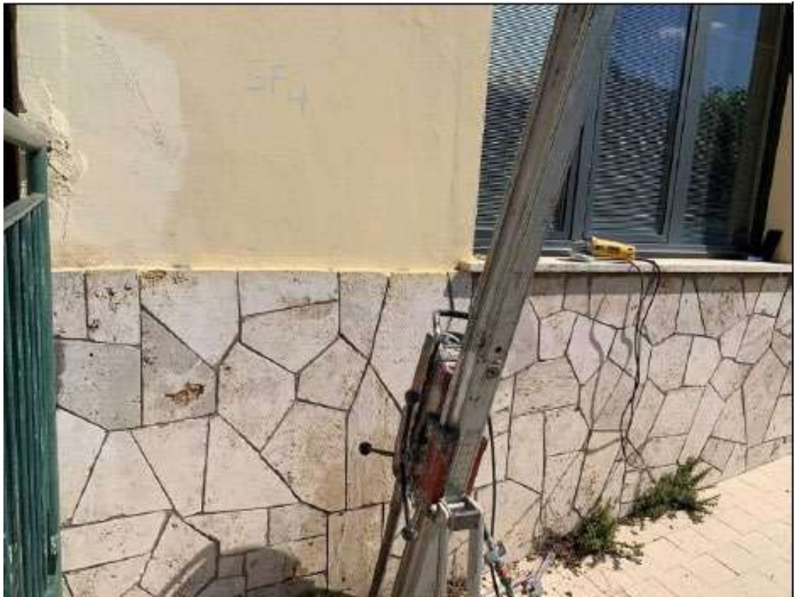
Foto 8 – Carotaggio inclinato nelle fondazioni – SF4 – Corpo A
