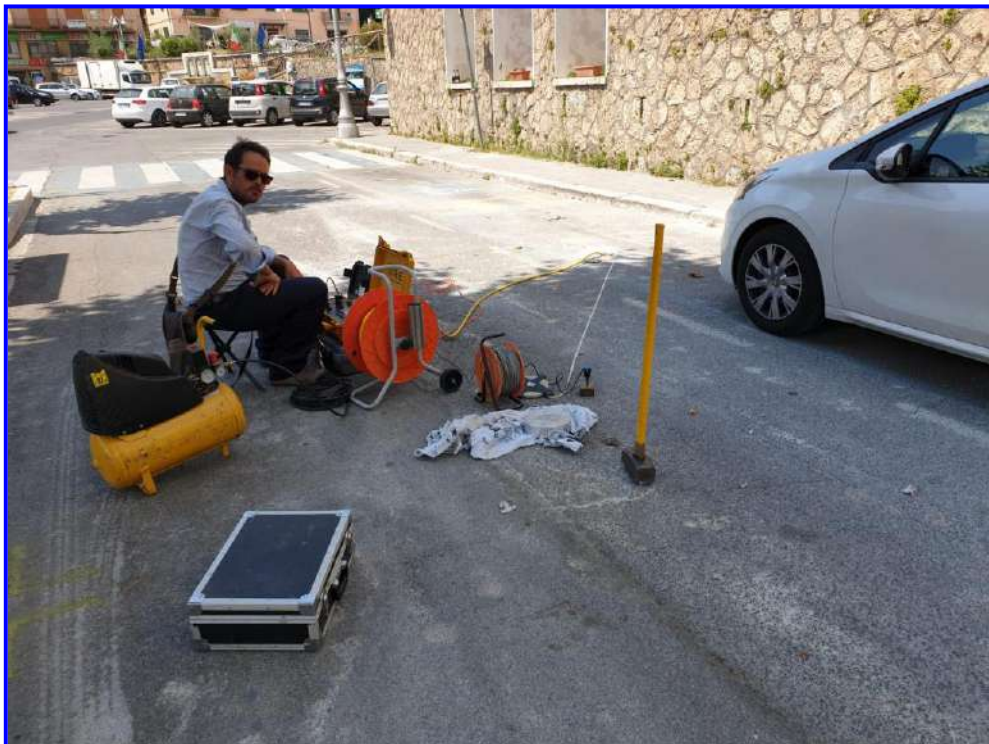
Prospezione sismica Down-Hole n.1
