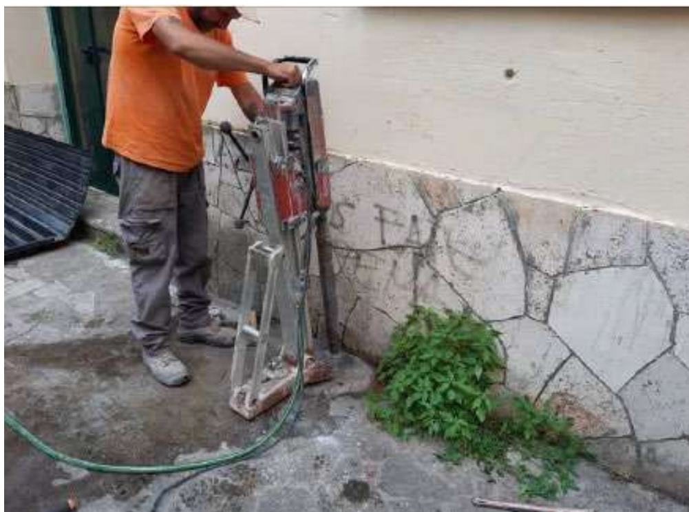
Foto 6 – Carotaggio iinclinato nelle fondazioni – SF2 – Corpo A
