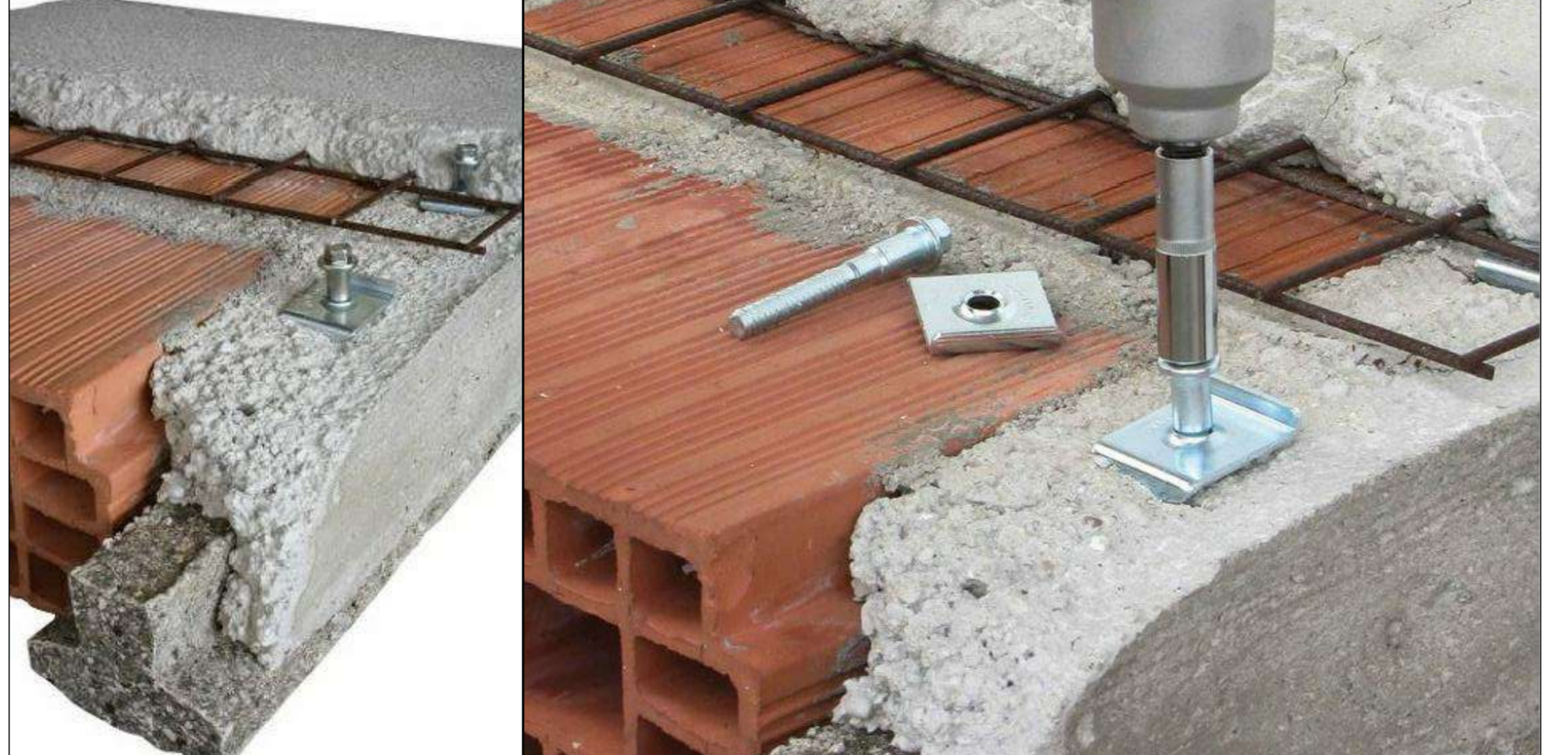
Intervento consolidamento solaio in latero-cemento
