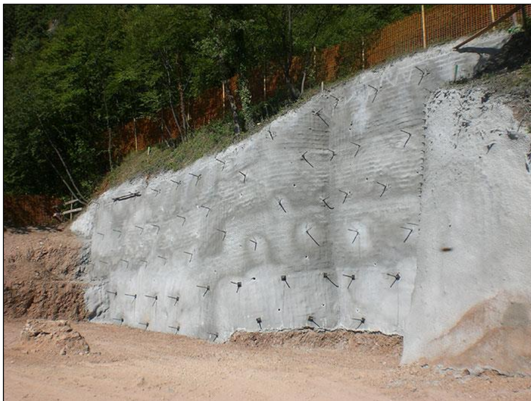
Figura 15 Sostegno in Spritz-Beton
