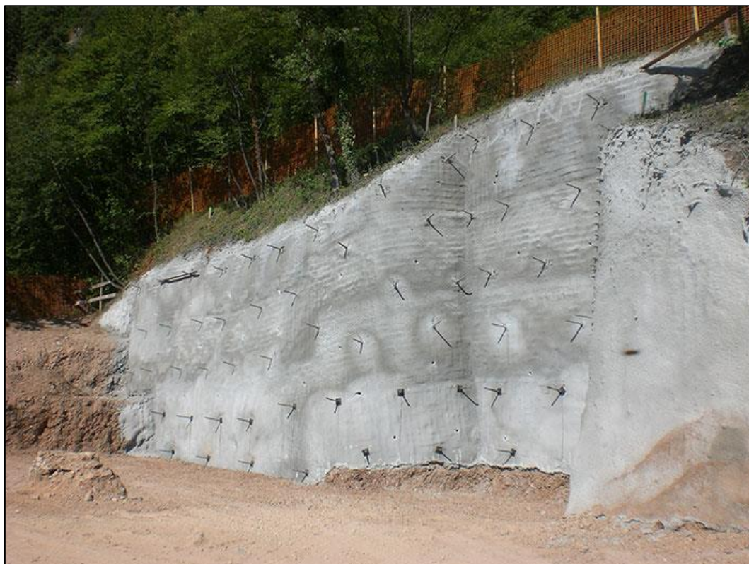
Figura 15 Sostegno in Spritz-Beton
