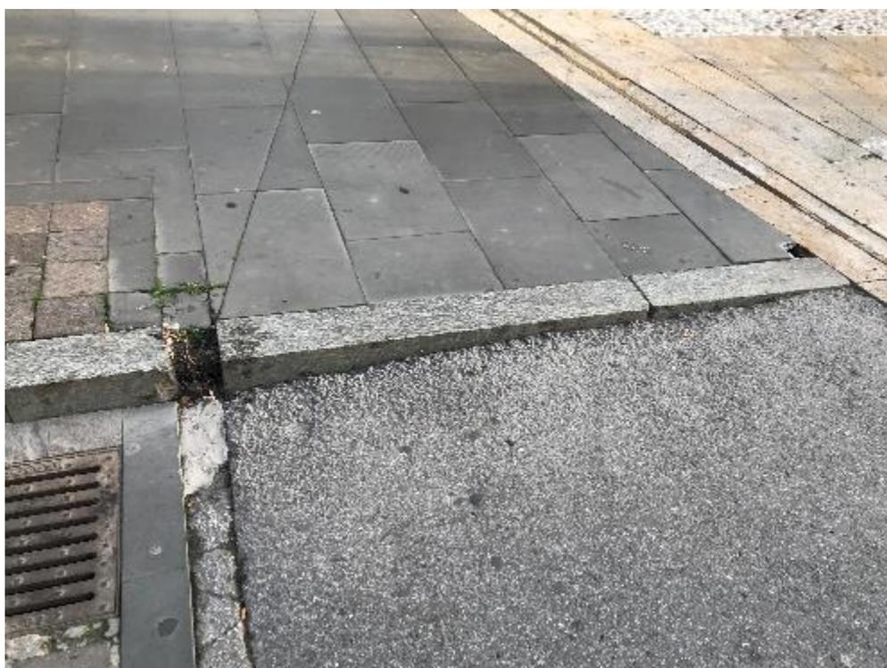
**Figura 10** Stato di degrado pavimentazione e cigli
