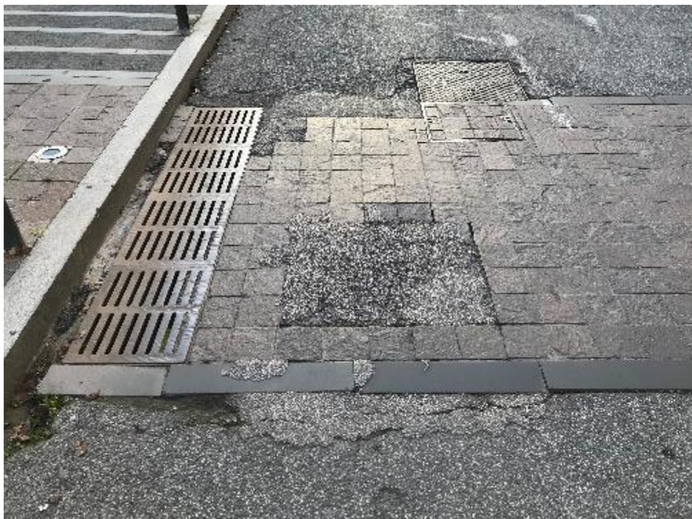
Figura 7 Pavimentazione degradata cubetti in porfido
