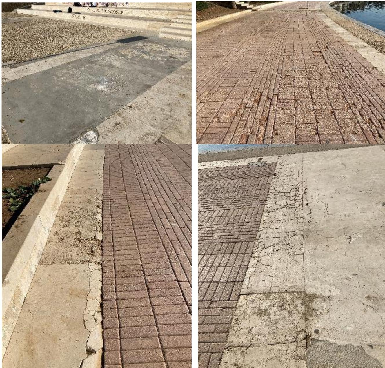
**Figura 5-8 Degradi delle pavimentazioni**
