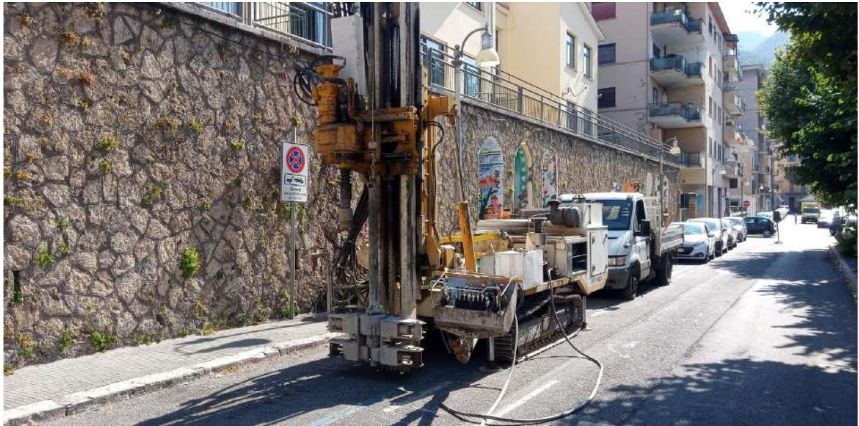
Postazione di sondaggio
