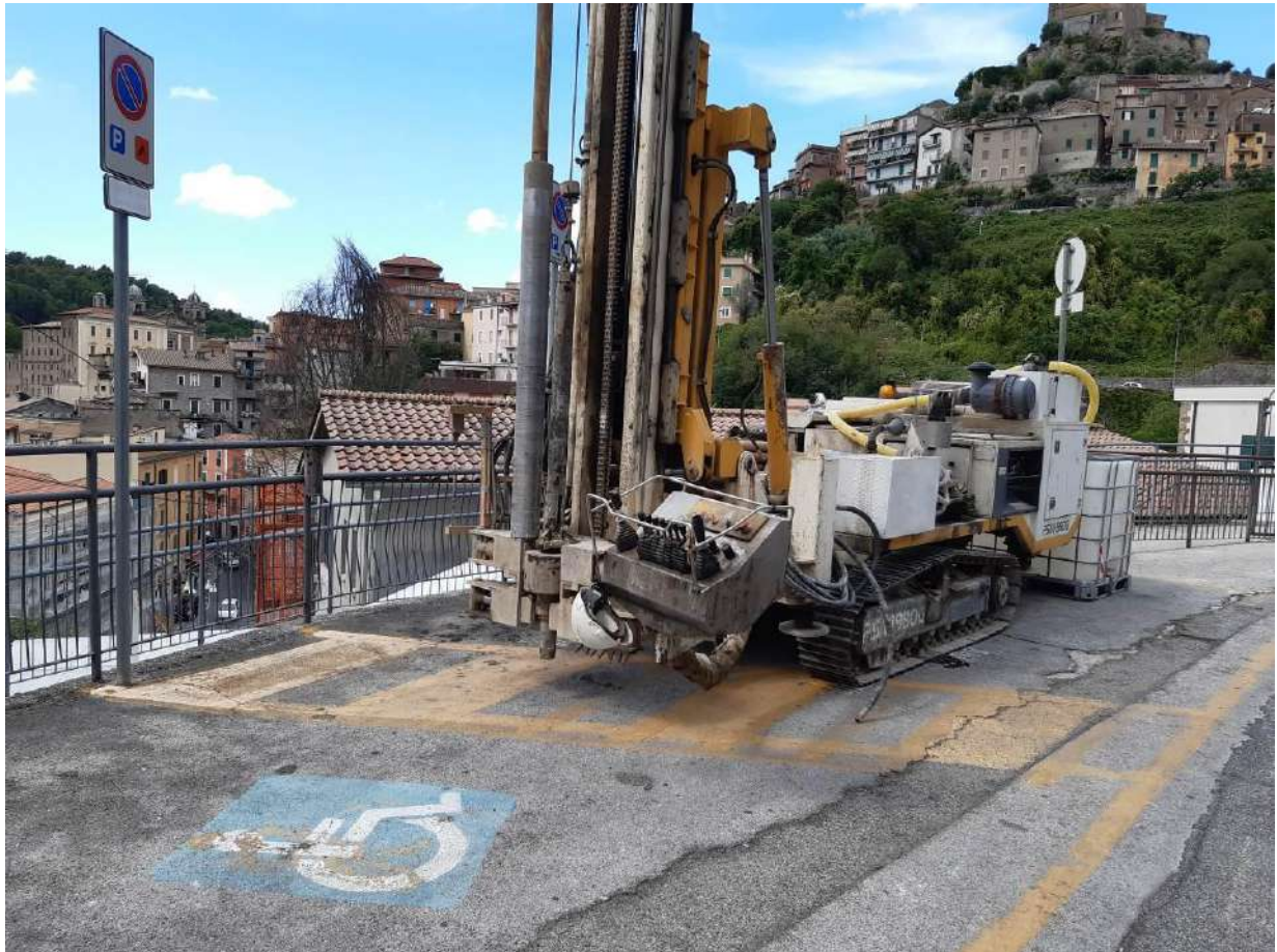
Postazione di sondaggio
