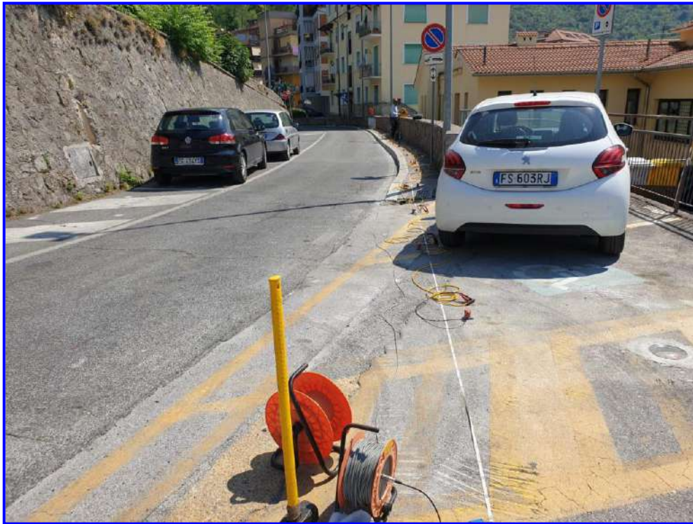
Prospezione di sismica a rifrazione / MASW n.1
