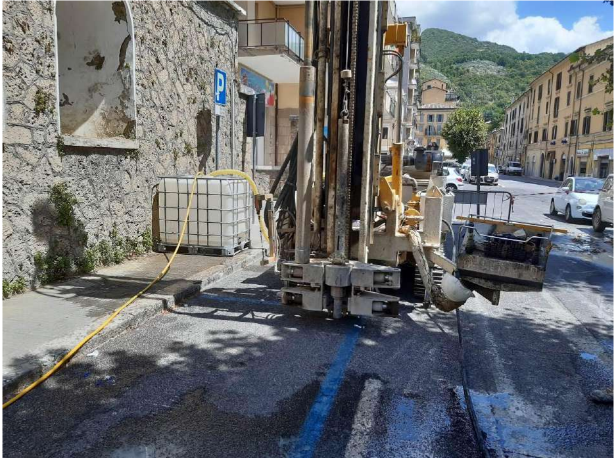
Postazione di sondaggio
