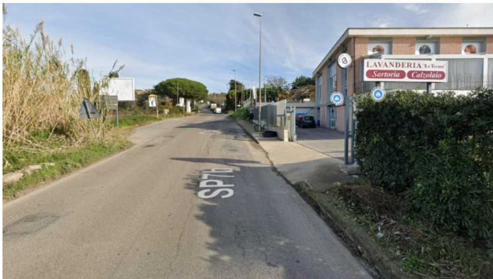
Tratto 4 – Realizzazione nuovo marciapiede (lato dx)
