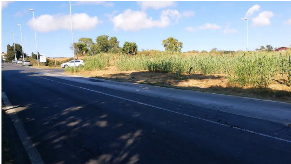
Tratto 3 – Realizzazione nuovo marciapiede
