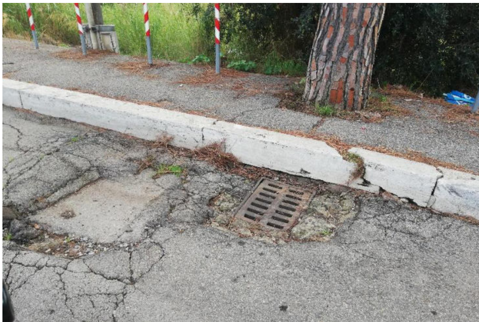
Tratto 1 – Riqualifica marciapiede esistente (demolizione e ricostruzione)
