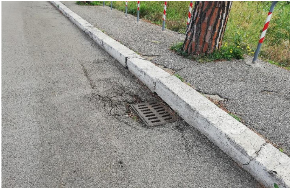
Tratto 1 – Riqualifica marciapiede esistente (demolizione e ricostruzione)
