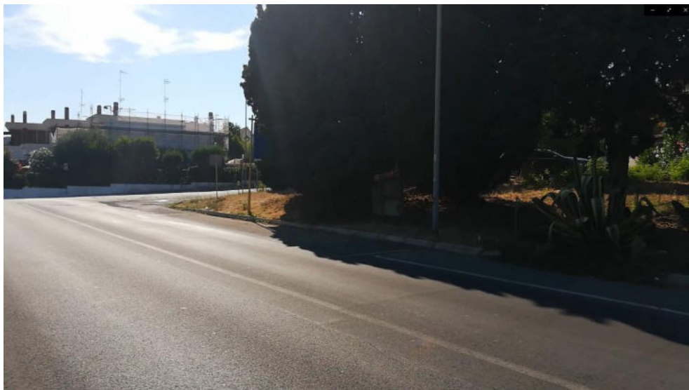
Tratto 5 – Realizzazione nuovo marciapiede (fermata autobus)
