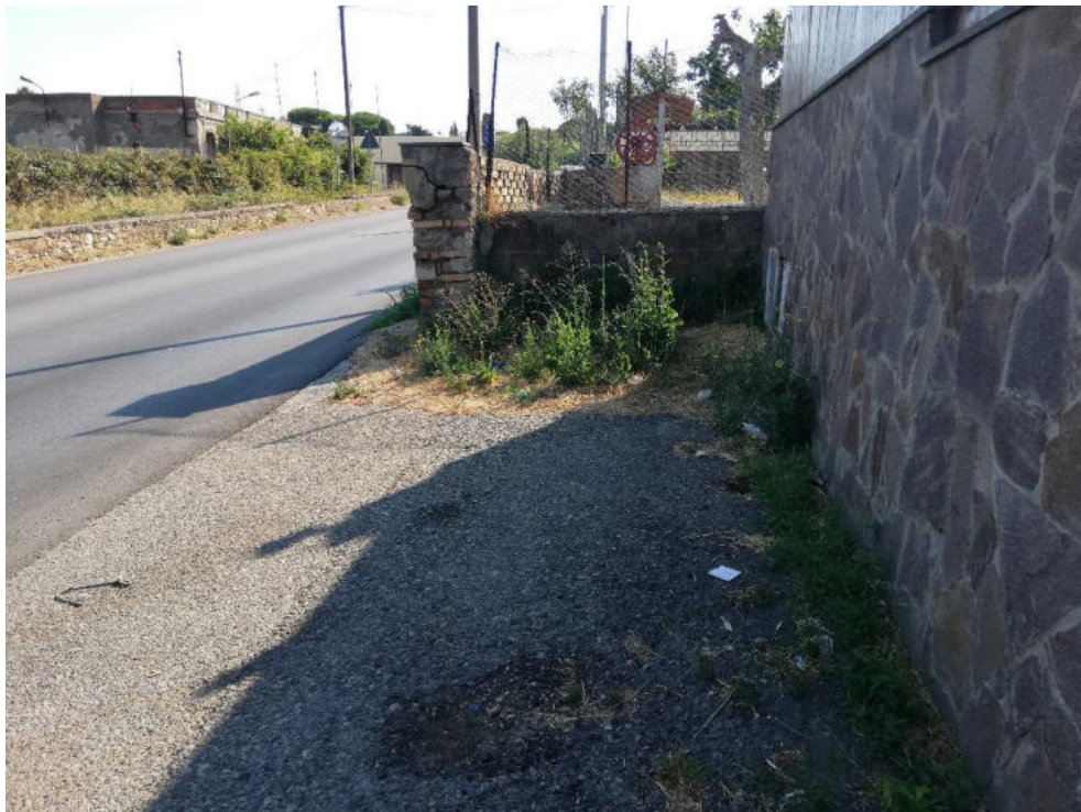
Tratto 3 – Realizzazione nuovo marciapiede
