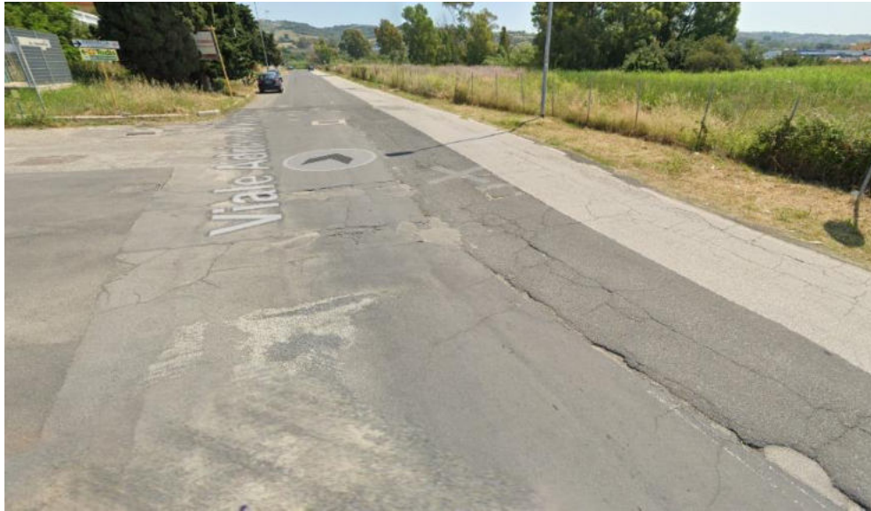
Tratto 4 – Realizzazione nuovo marciapiede (lato dx)
