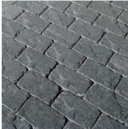
Esempio pavimentazione tipo "Sampietrino"
