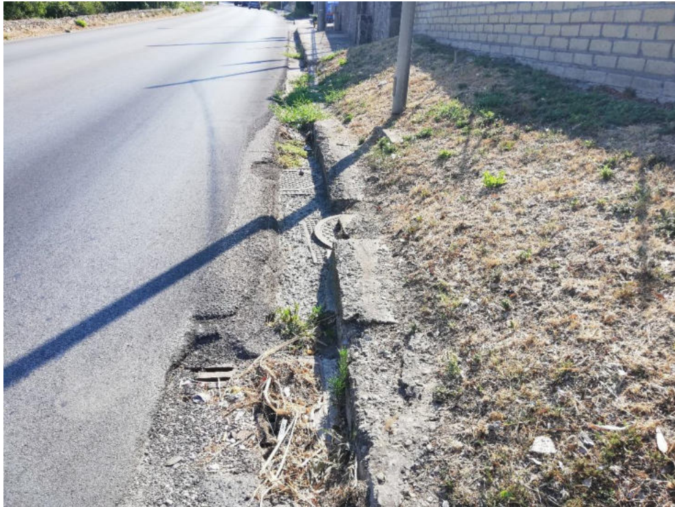
Tratto 9 – Riqualifica marciapiede esistente (demolizione e ricostruzione)
