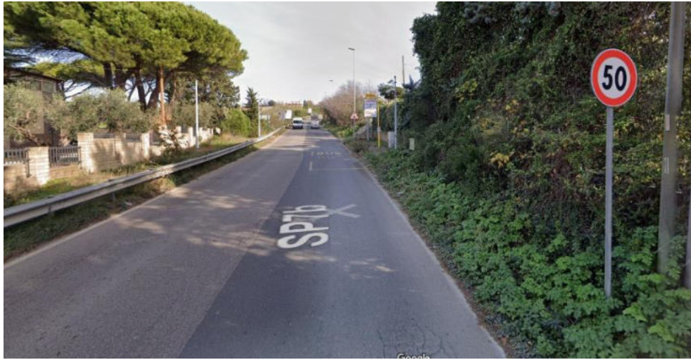
Tratto 5 – Realizzazione nuovo marciapiede (lato sx)
