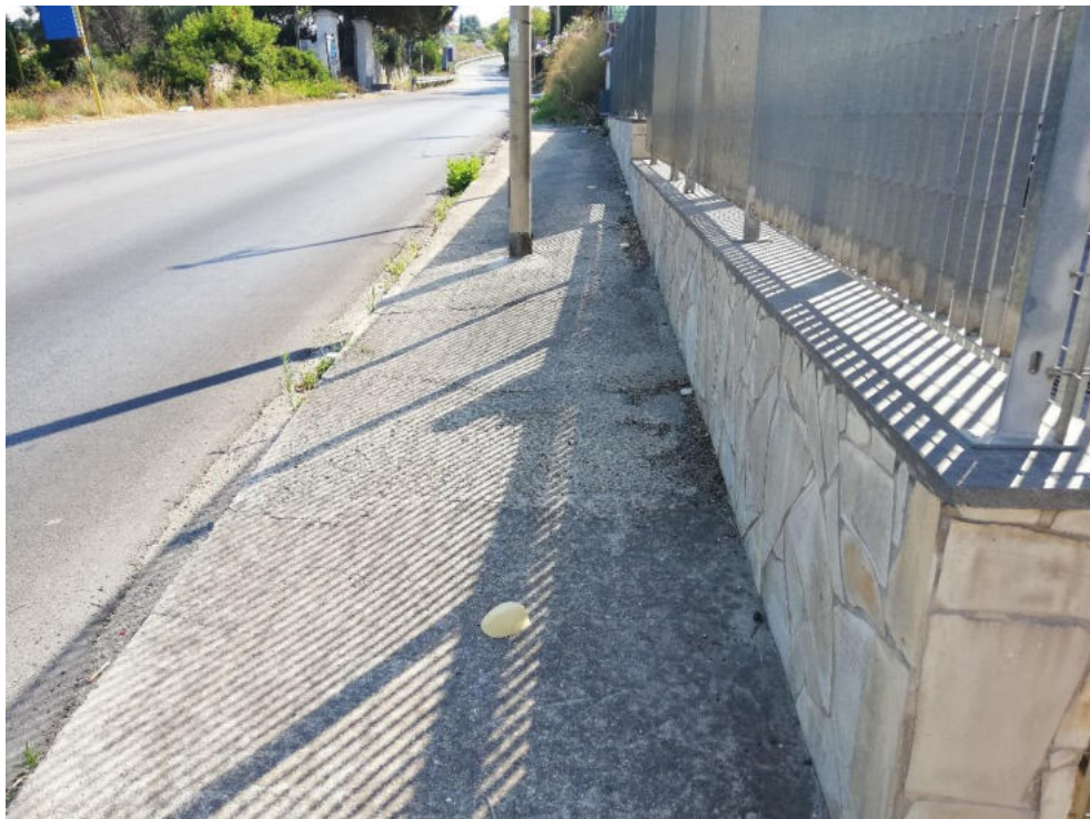
Tratto 11 – Riqualifica marciapiede esistente (demolizione e ricostruzione)
