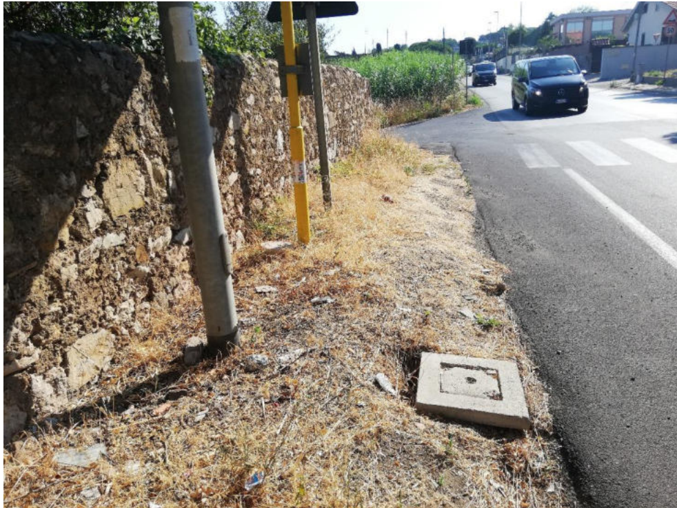
Tratto 1 – Realizzazione nuovo marciapiede
