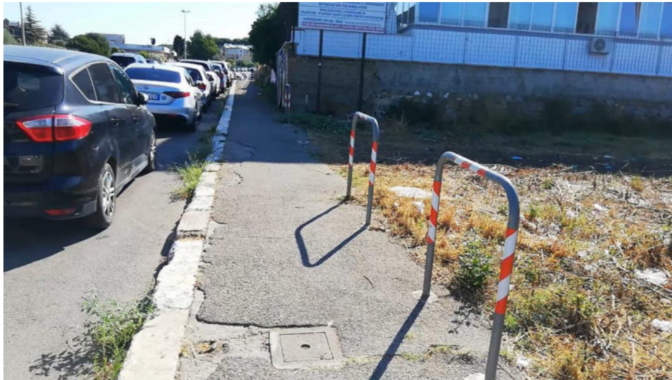
Tratto 8 – Riqualifica marciapiede esistente (ripavimentazione)
