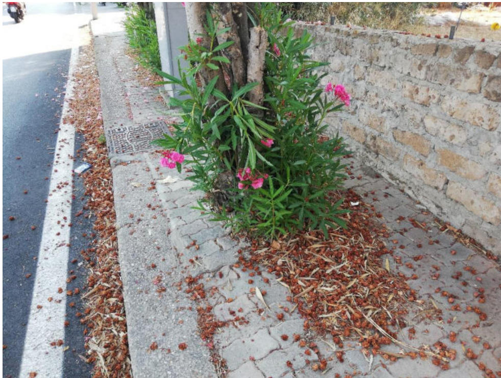
Tratto 6 – Riqualifica marciapiede esistente (demolizione e ricostruzione)
