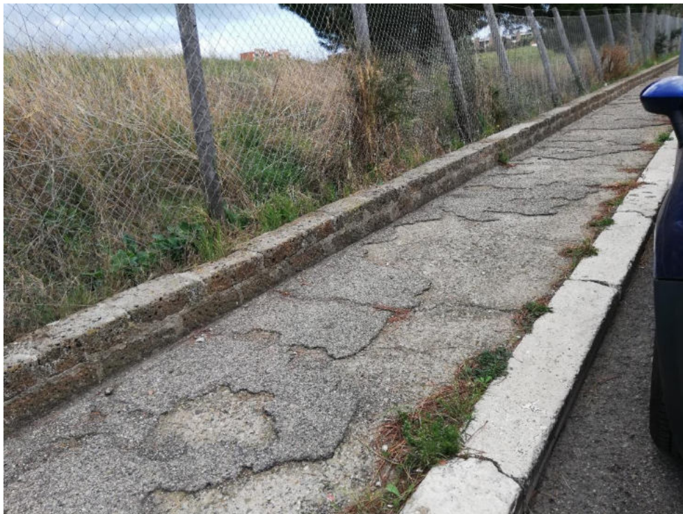
Tratto 6 – Riqualifica marciapiede esistente (ripavimentazione)
