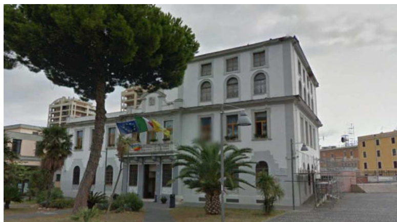
Vista prospetto principale (nord) – Sede Comunale
