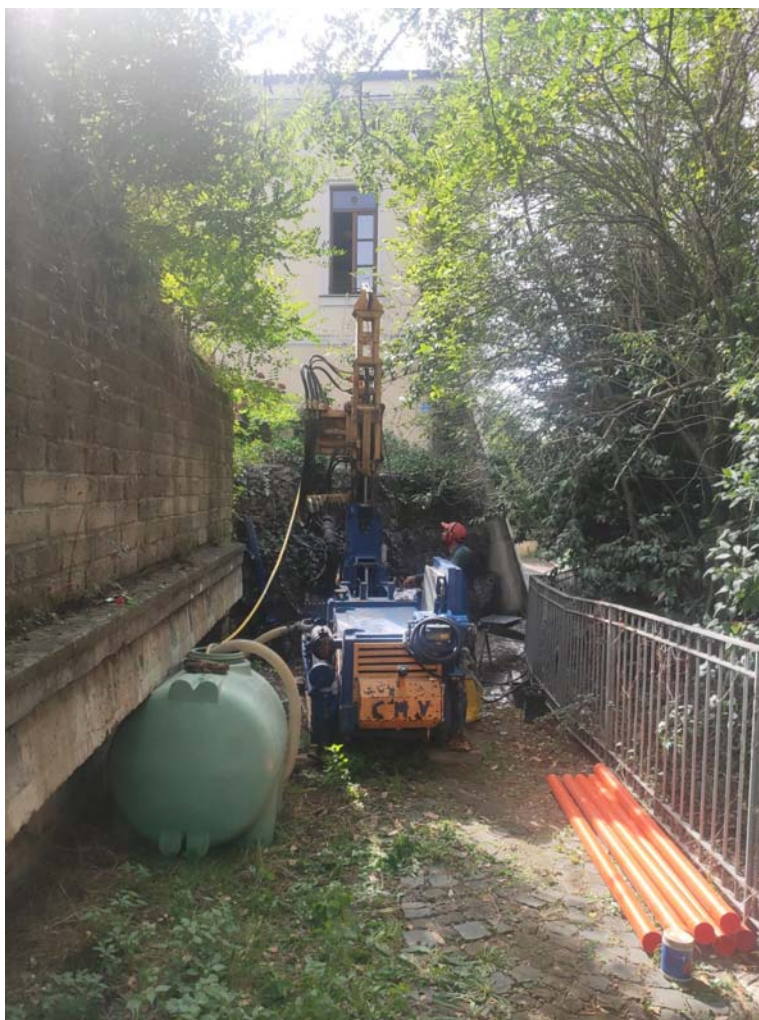
Figura 5: momento durante il sondaggio geognostico
