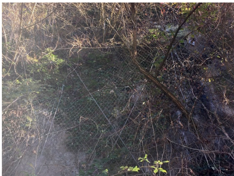
Foto 1- rete e funi metalliche per rinforzo corticale
