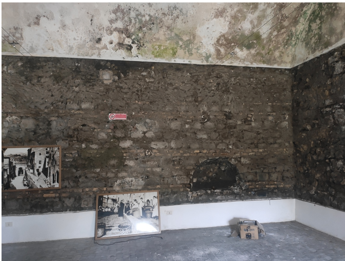
Figura 10: particolare della grotta di Villetta Ortensia soggetta a infiltrazioni
