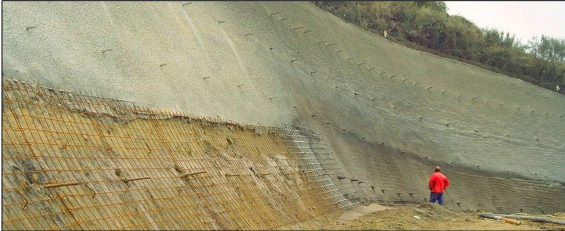
Figura 16 Esempio di realizzazione di parete chiodata
