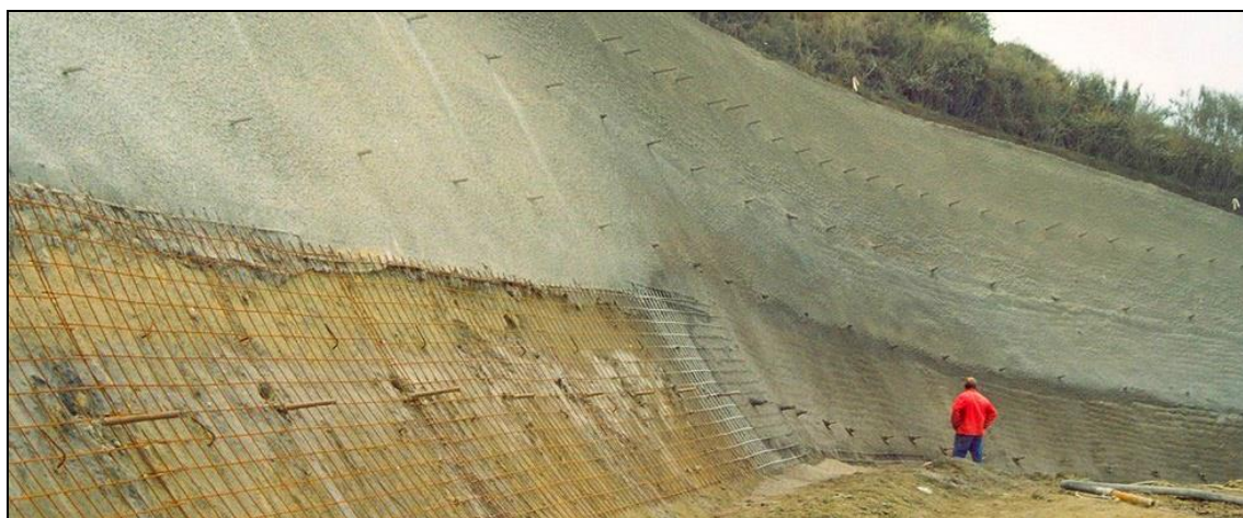
Figura 15 - Esempio di realizzazione di parete chiodata
