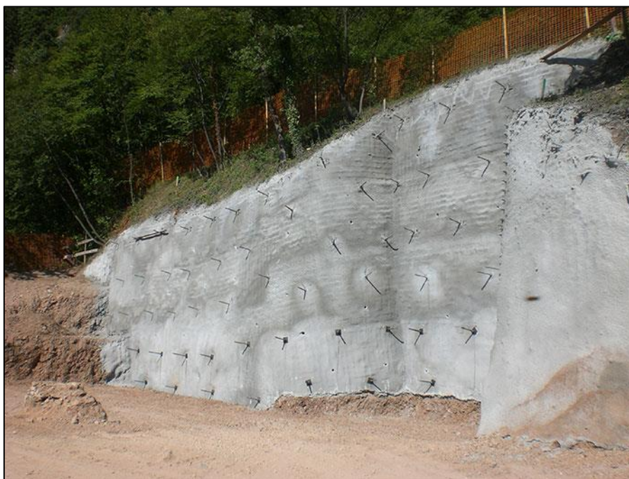
Figura 15 Sostegno in Spritz-Beton
