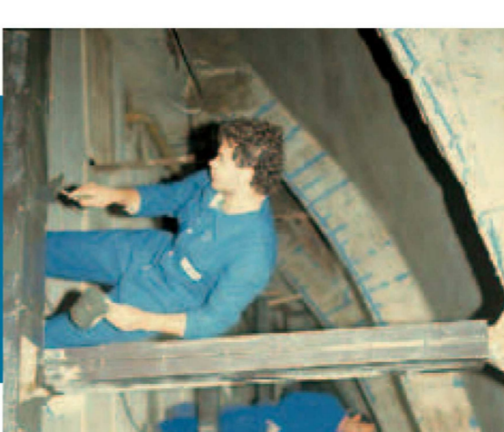
Getto con Mergolite Colabile in cassero metallico
