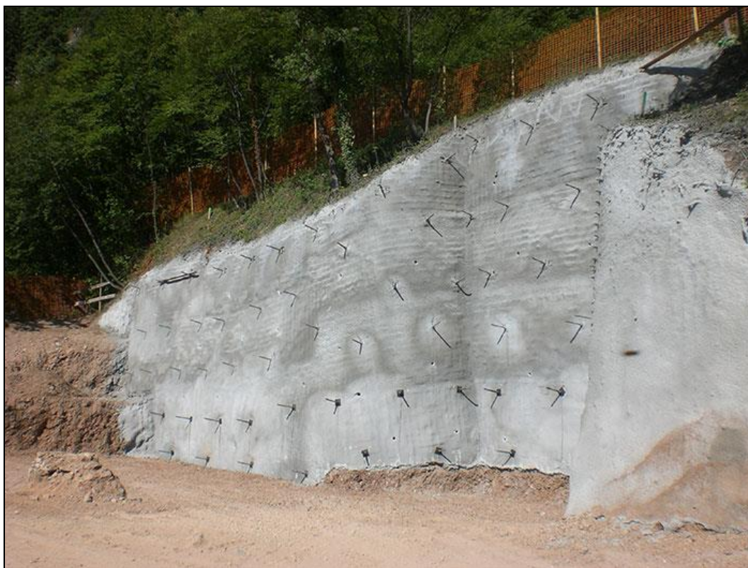
Figura 13 - Rinforzo parete tramite Spritz - beton
