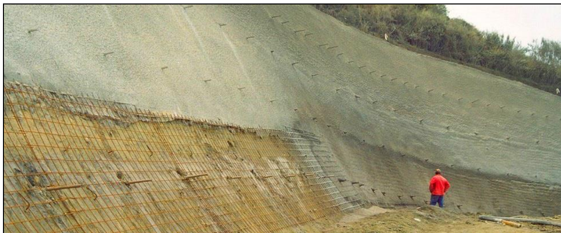
Figura 13 - Esempio di realizzazione di parete chiodata
