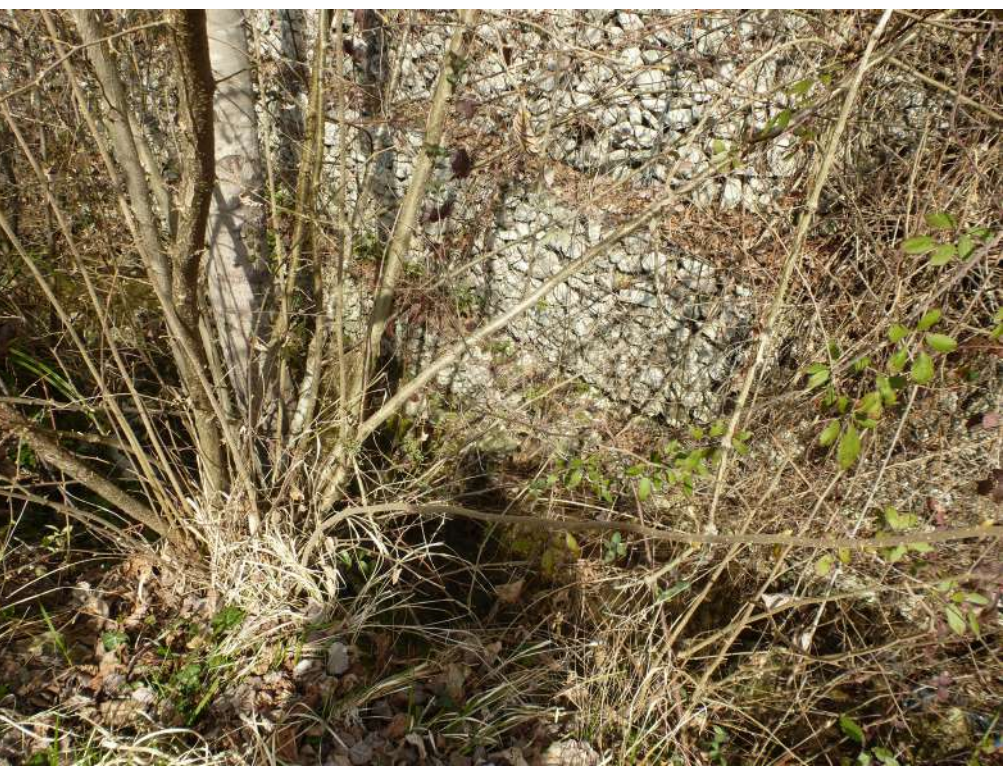
Foto 11 - parte di gabbioni in dissesto da rimuovere e rifare
