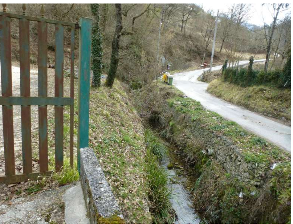
Foto 18 - alveo con dissesto bordo strada e gabbioni da sistemare
