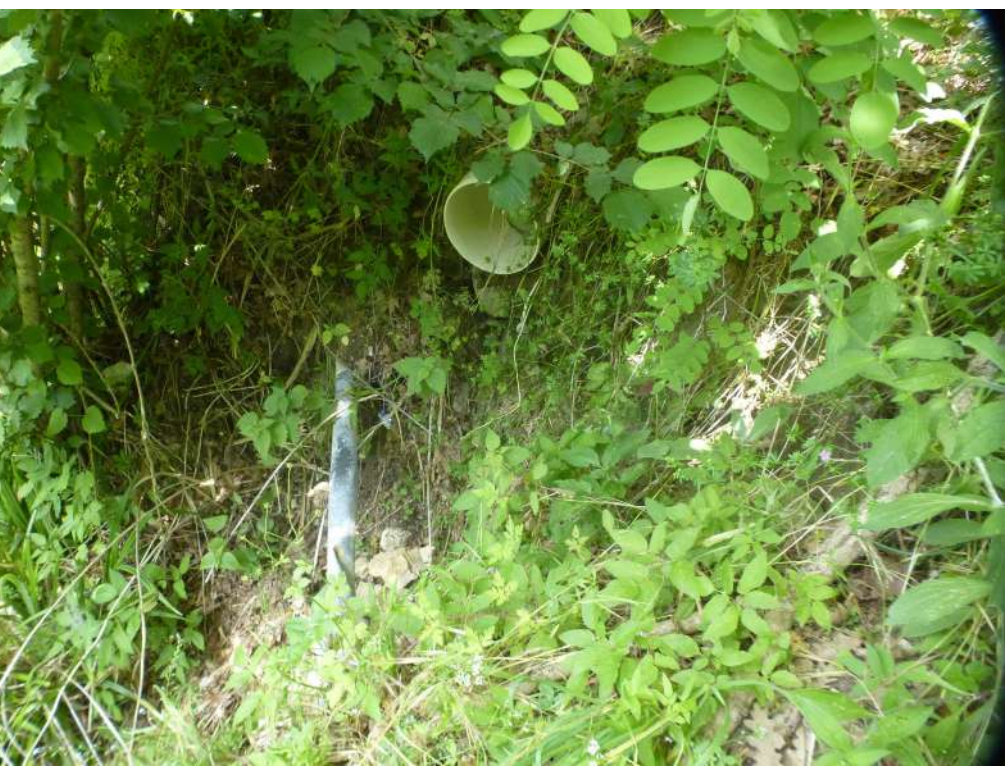
Foto 7 - alveo in frana a margine strada, con scarico acque piovane
