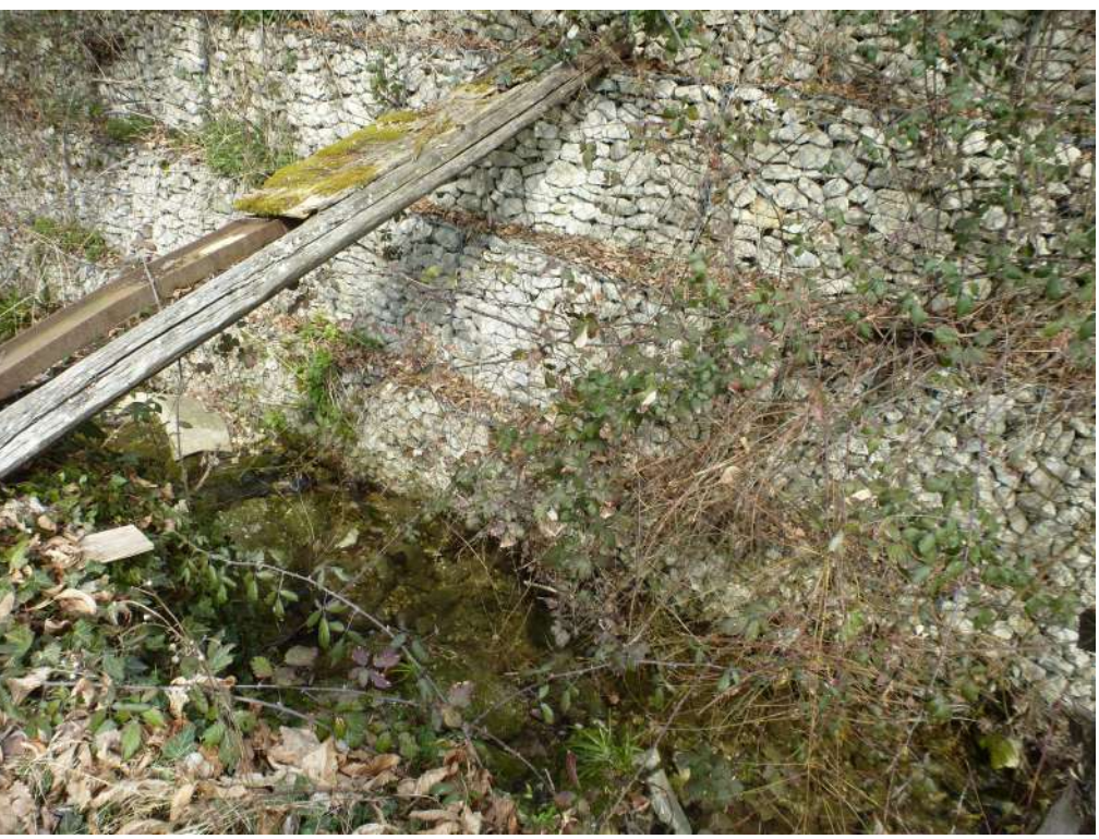
Foto 9 - scalzamento gabbioni esistenti
